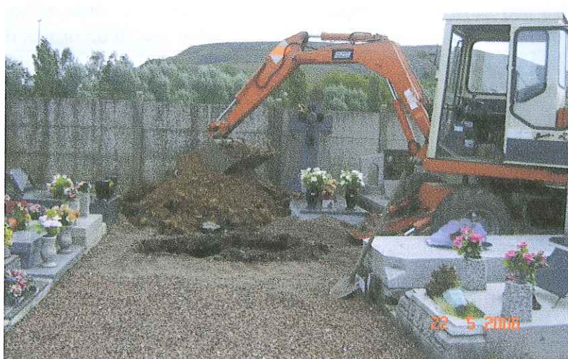
Vue de la tranchée T2 en bordure sud.
