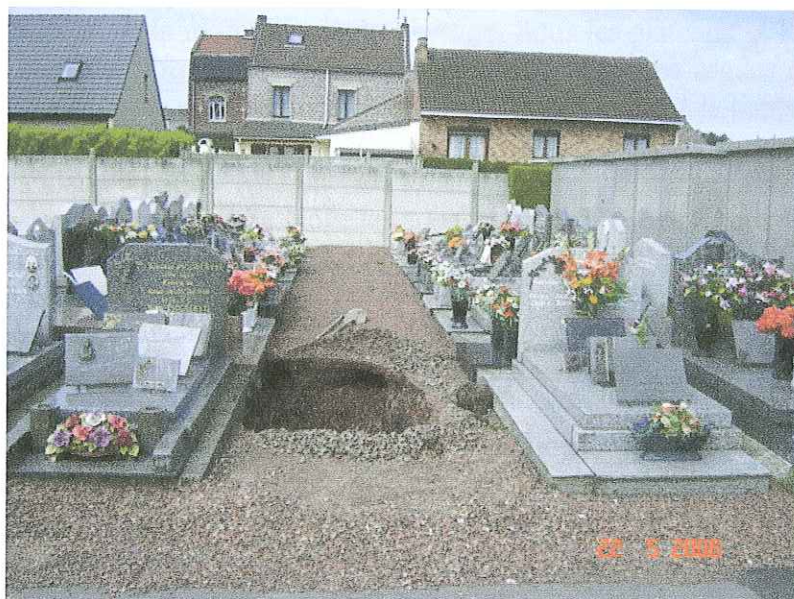
Vue de la tranchée T1 en bordure est
