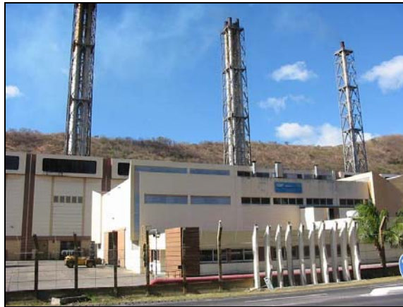
La centrale électrique de Bellefontaine
