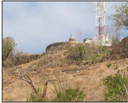
Réservoir du Bourg
