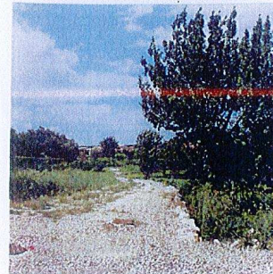
Construction d'une nouvelle route pour aider à l'extension
