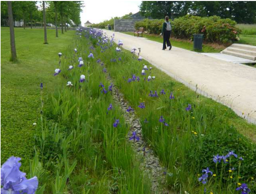
Des noues / fossés accompagnent un cheminement
