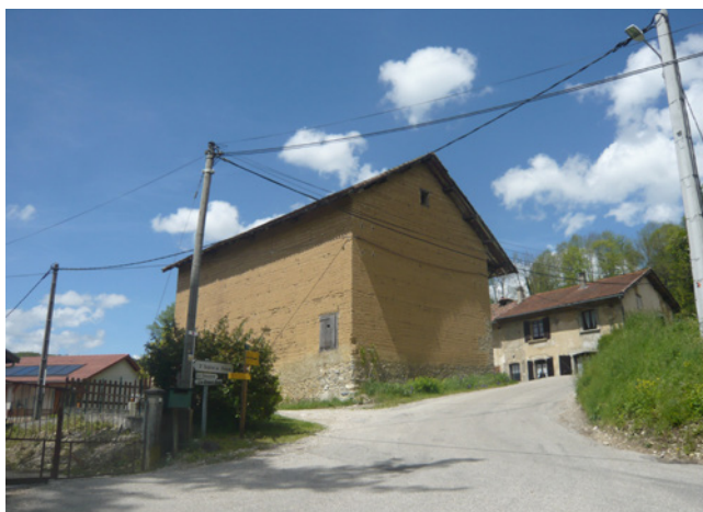
Une grange en pisé isolée du bâtiment d'habitation. Les ouvertures dans ce type de bâtiment sont à encadrer fortement, elles sont à réaliser avec délicatesse (bois plutôt que béton) et avec soin. Les enduits ciments ou plastique sont à proscrire : ils entraîneront à terme de fortes dégradations en maintenant l'humidité dans les murs.
