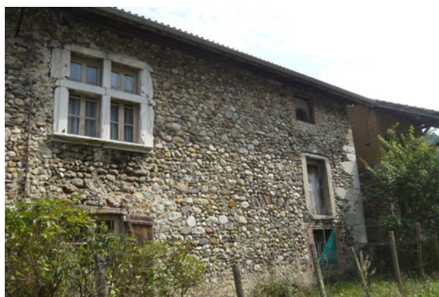
Ferme avec fenêtre à meneau la Mérie (récupération ?)
