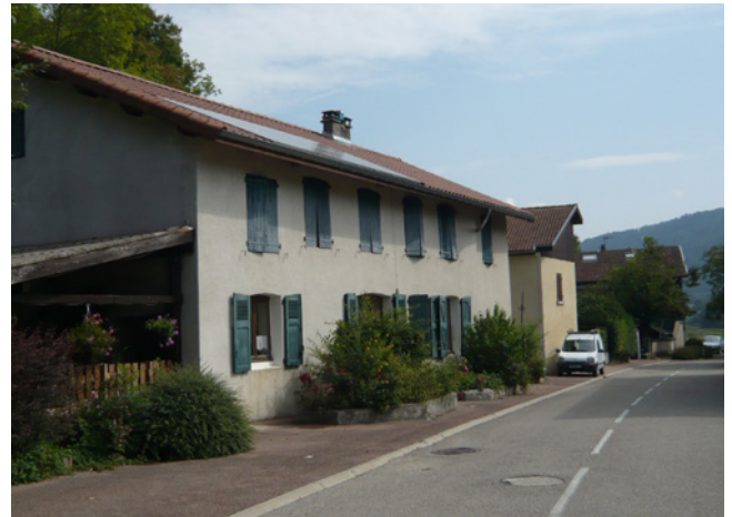
Des maisons de village. Les façades sont composées, les ouvertures se superposent, les fenêtres sont toujours nettement plus hautes que larges (de plus elles sont ici cintrées), les volets sont peints (meilleure pérennité du bois qu'avec les lasures).
