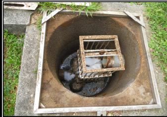
Entrée PR - Dégrilleur
