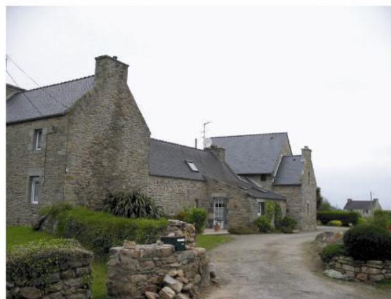
Rénovation à Vourch
