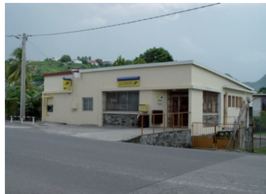
le bureau de poste du Carbet source : a4+a - architecture & ateliers
