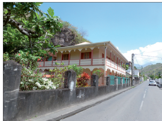
la maison Balthazard source : a4+a - architecture & ateliers
