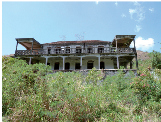
la maison Madkaud source : a4+a - architecture & ateliers
