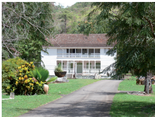
la maison Bally source : a4+a - architecture & ateliers
