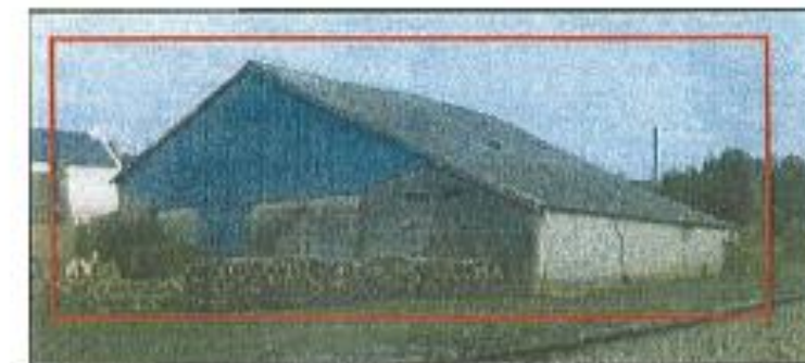
Hangar agricole : non conservé
