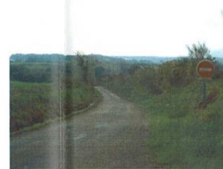
FOSSÉ PROFOND CÔTÉ EST ET TALUS DE PART ET D'AUTRE DE LA VOIE COMMUNALE DU STADE
