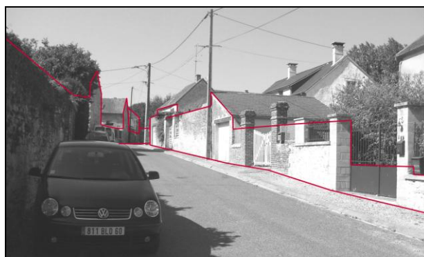
Continuité visuelle rue de la vacherie
