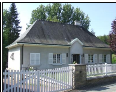
Architecture pavillonnaire avec toiture à croupe et coyaux
