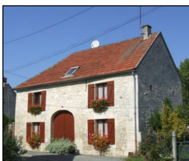
Ancien corps de ferme en moellon et chaînage pierre à étages (R+1+C)
