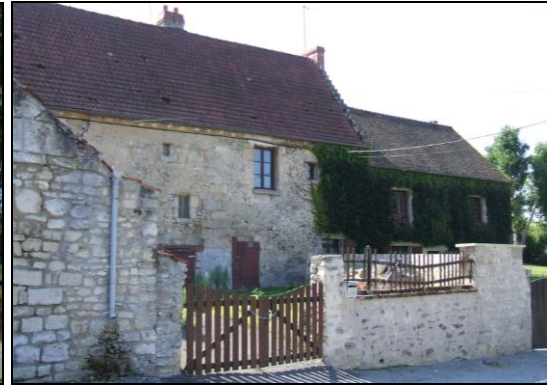
Maisons en moellons à deux niveaux (R+1+C)
