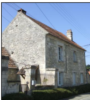
Construction R+1+C en moellons et pierres de taille pour les chaînages d'angle
