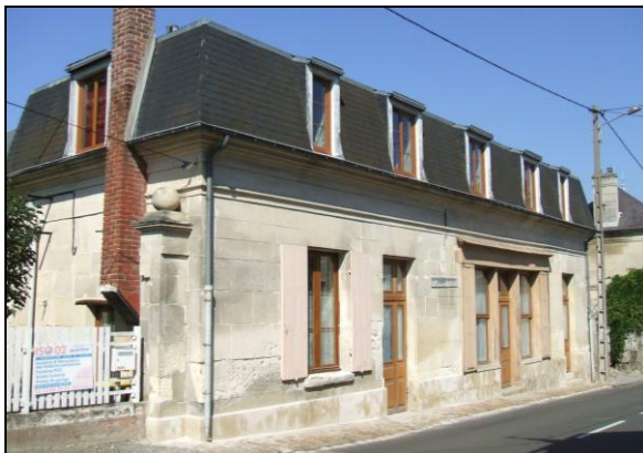
Ancien commerce transformé en habitation Construction en pierre de taille avec toiture à terrassons
