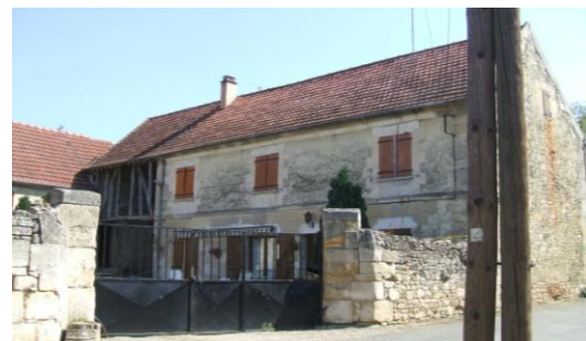
Corps de ferme à la volumétrie allongée
