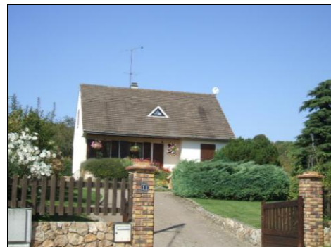
Le pavillon R+C avec clôture en meulière
