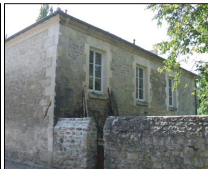
Sur large lucarne à débord de toiture murs en moellons avec couronnement
