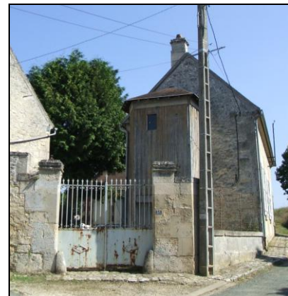
Escalier extérieur sur habitation en pierres à étages (R+1+C)
