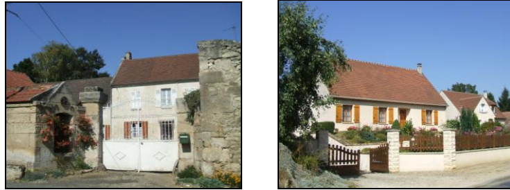
Maison d'habitation en pierres à 2 niveaux et construction pavillonnaire aux matériaux standardisés.
