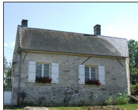
Maison rurale en moellons à 1 niveau
