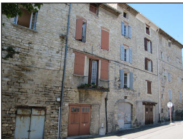
Front bâti le long de la rue des Moulins.
