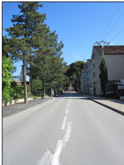
La cave coopérative (à droite) marque l'entrée sud dans le centre, elle est poursuivie par un alignement remarquable de pins
