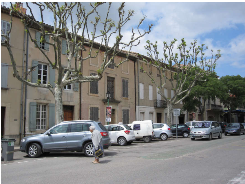
Continuité bâtie sur le front Ouest du village
