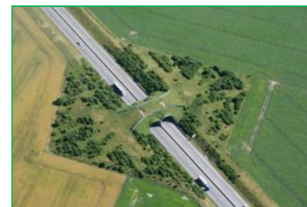
Exemple de passage à faune sur une autoroute
