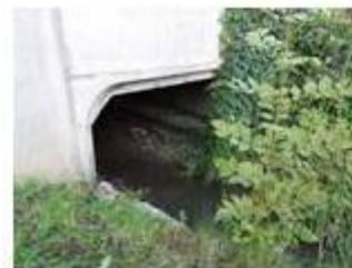
Ouvrage hydraulique avec banquette sous la RD66
