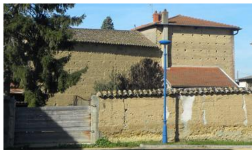
Murs et façades en pisé dans le bourg
