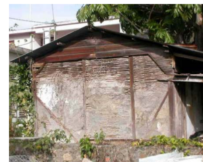
Maison de pêcheur en gaulettes, murs en bois tressés et torchis- 1 ère moitié du 20 ème siècle
