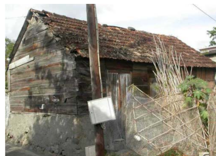
Maison de pêcheur en moellons sans chaîne en pierre de taille, enduit et bois -1920
