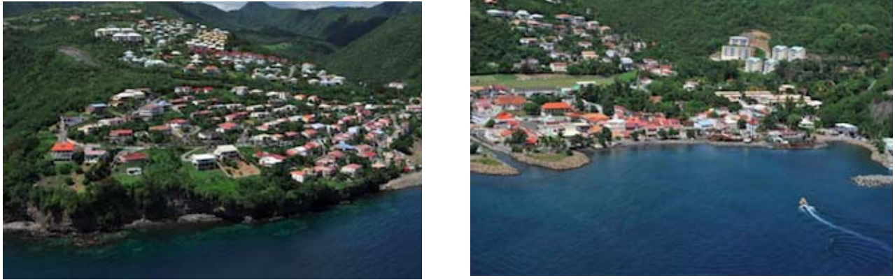
Figure 4 : Urbanisation littorale et des crêtes, Bourg de Case-Pilote, Photographies Agence des 50 Pas, 2016
