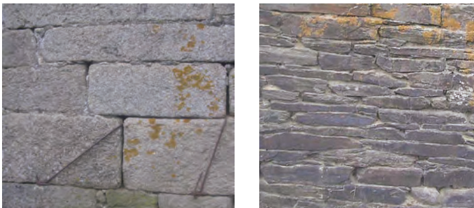
Un appareillage serré nécessitant un léger jointoiment
