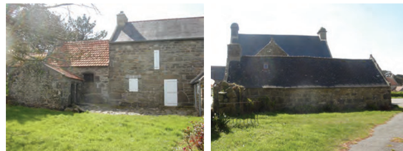
Les matériaux d'origine peuvent être maintenus mais l'ardoise est le matériau traditionnel
