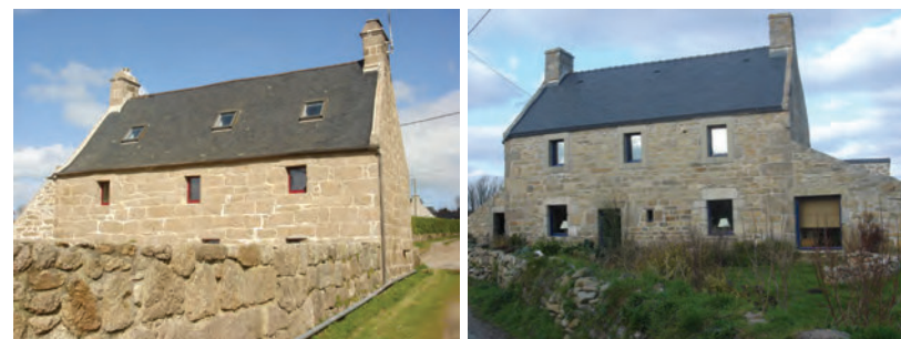
Exemples de plein vitrage harmonisé sur l'ensemble de la façade
