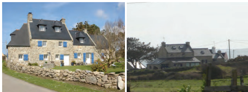
Une toiture à croupe (et des lucarnes), ou la multiplication d'extension qui modifie la perception de la construction d'origine
