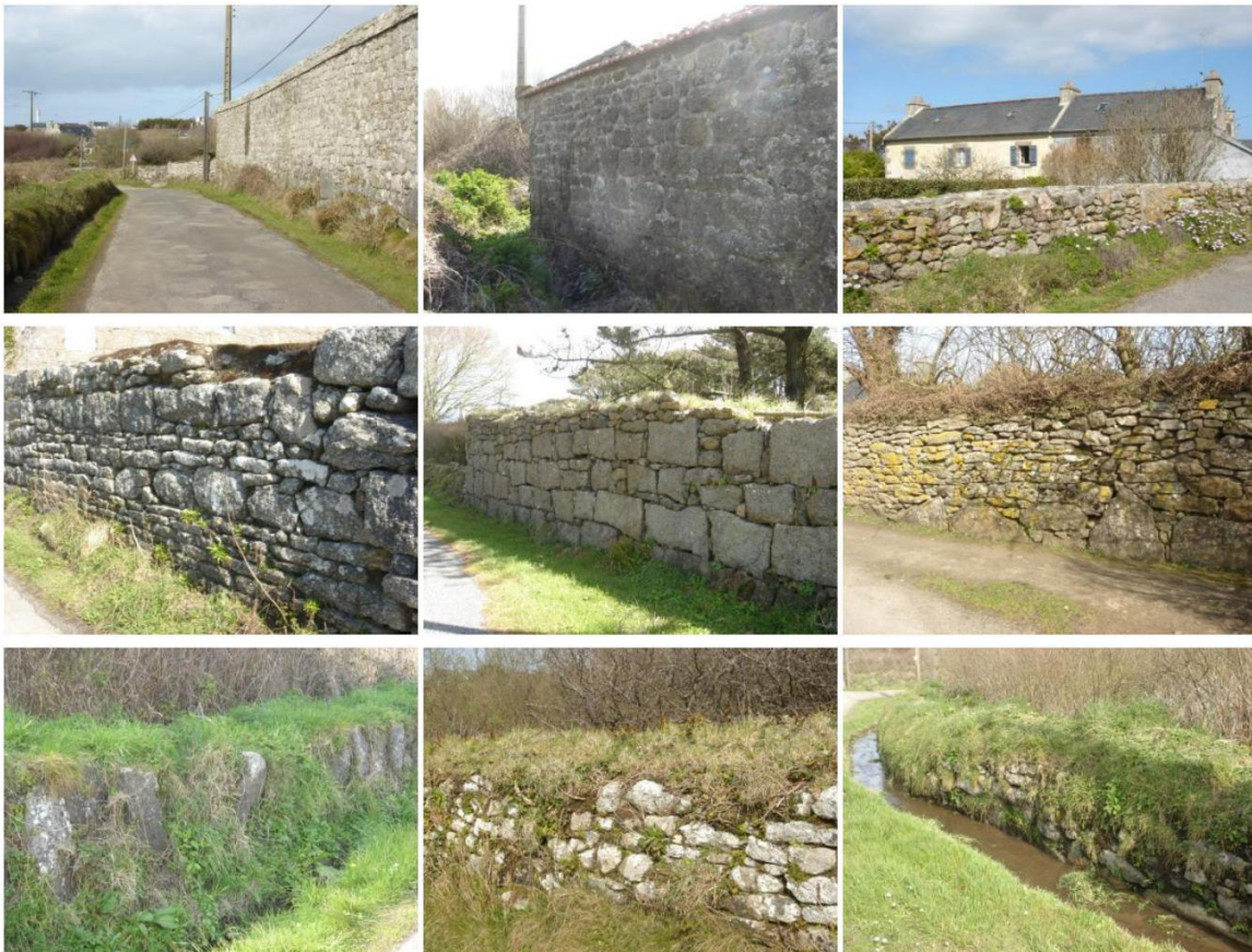
Murs et murets
