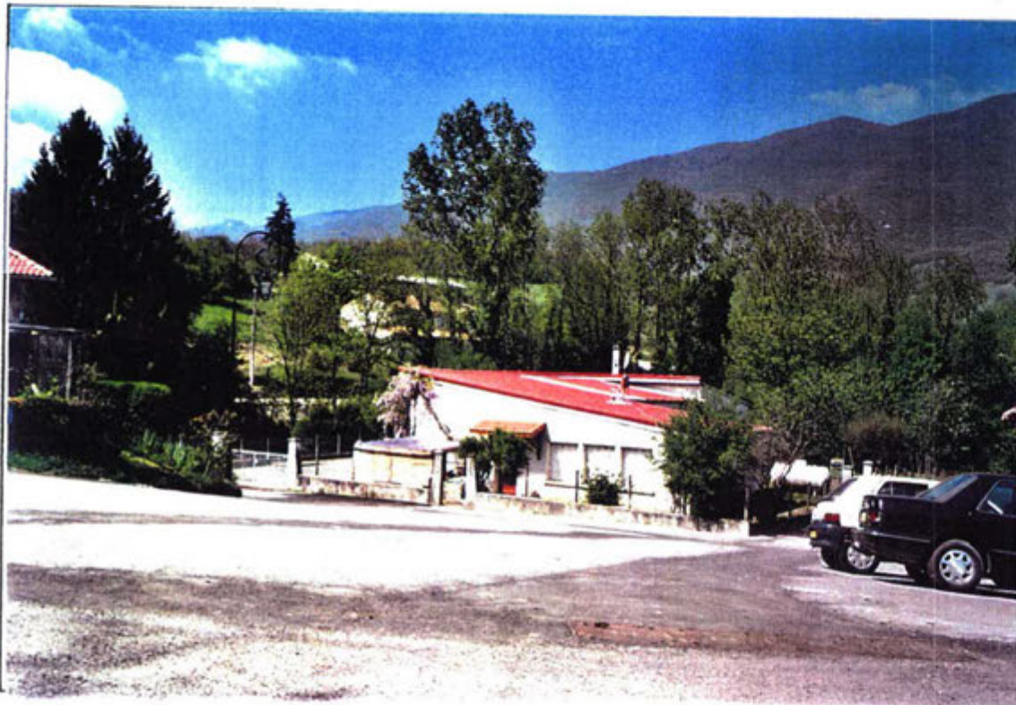
L'ancienne école, transformée aujourd'hui en salle polyvalente
