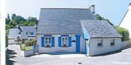
Au sud, habitation au contact de la rue
