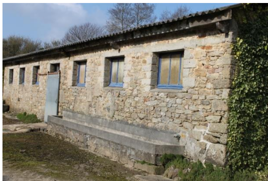
Keroualar bâtiment 1 (parcelle 56)
