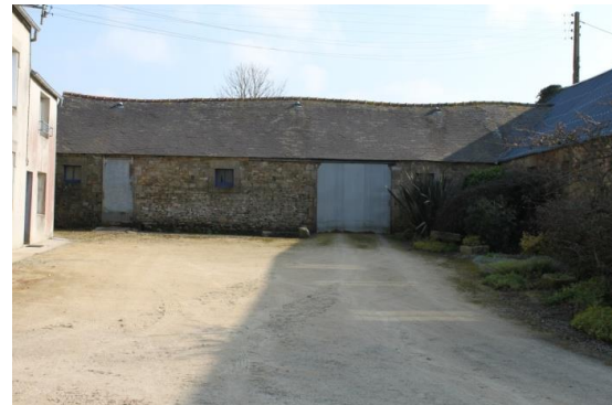
Keroualar bâtiment 2 (parcelle 56)
