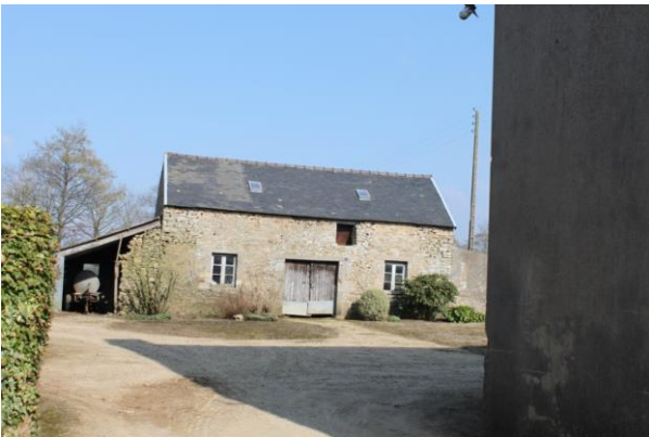
Keroualar bâtiment 3 (parcelle 56)
