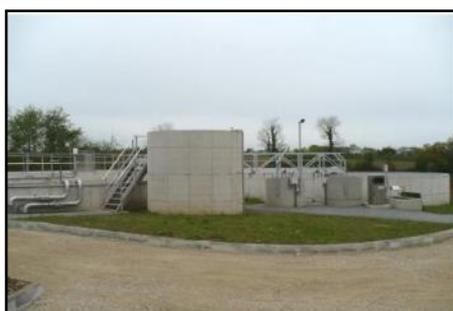
Les eaux usées sont acheminées vers la station d'épuration du Moulin de Tréléon de type boue activée située sur la commune de Milizac et mise en service en février 2009. La gestion de la station d'épuration s'effectue en régie directe par les services municipaux, avec l'assistance technique du Service de l'Eau et de l'Assainissement du Département du Finistère.
