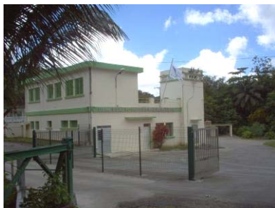
La station de traitement de l'eau de Saint-Joseph à Durand
