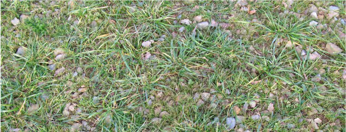
Revêtement de parking non imperméabilisé, réalisé en « herbe renforcée » (mélange terre-pierres, avec possibilité d'utiliser la terre prise sur place). Source : CAUE de l'Aveyron (photo : mélange de terre et de pierre ou « herbe renforcée »).
