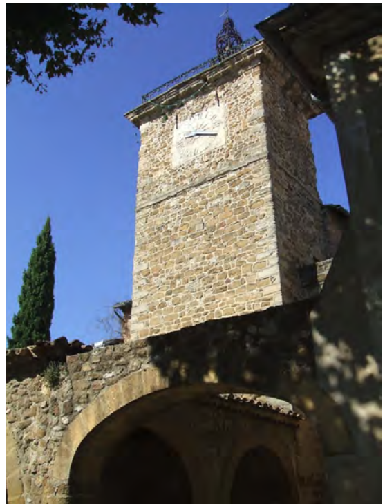
Porte de France et la portion de courtine du XIVe siècle (mâchicoulis sur consoles, chaînage d'angle à harpe, cadran solaire gravé en 1708, cadran de l'horloge, etc.)
