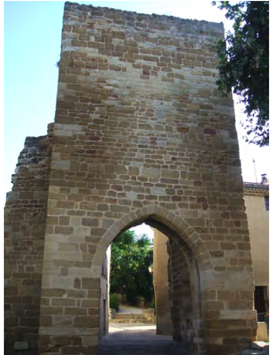
Portail Neuf du XIVe ou XVe siècle avec sa glissière de la herse, les traces de ses deux portes, etc.
