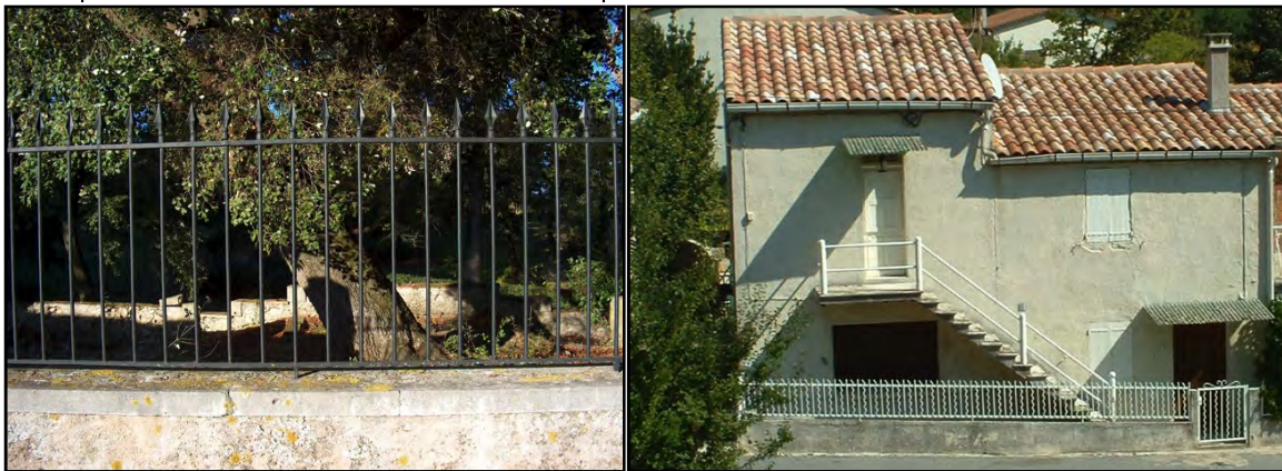
Exemples de clôtures autorisées sur domaine public
