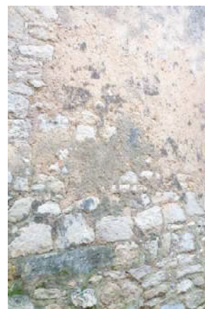
enduit à pierres vue sur façade agricole
