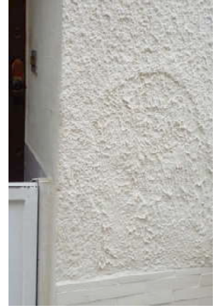
enduit épais qui bloque la respiration du mur
