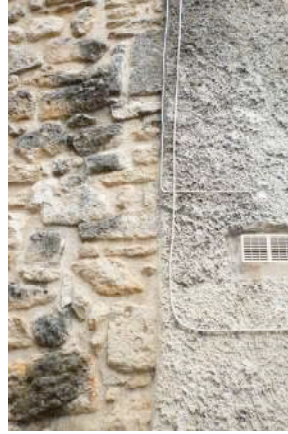
décroûtage "abusif": le creusement des joints crée des pièges à eau
