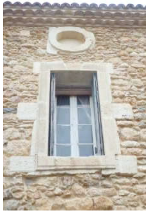
décroûtage "abusif": le creusement des joints crée des pièges à eau
