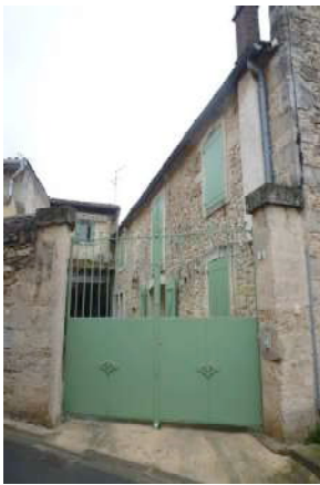
maison agricole : rdch agricole, façade en moellons à enduire. étage d'habitation en pierres de Castries appareillées souvent apparentes
