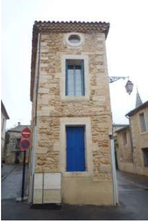
décroûtage "abusif": le creusement des joints crée des pièges à eau
