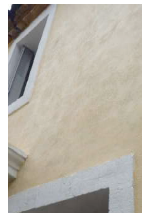
enduit à la chaux taloché fin
