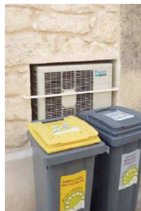
intégration d'un climatiseur
