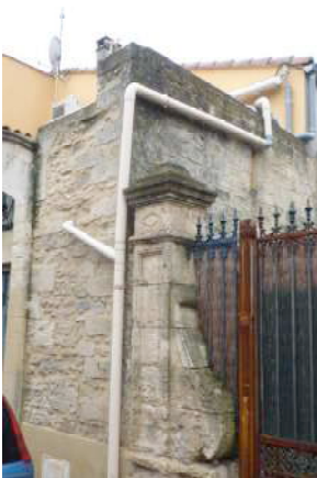
Tuyaux : la façade est la gaine technique de l'immeuble
