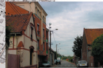
petit collectif en front à rue
