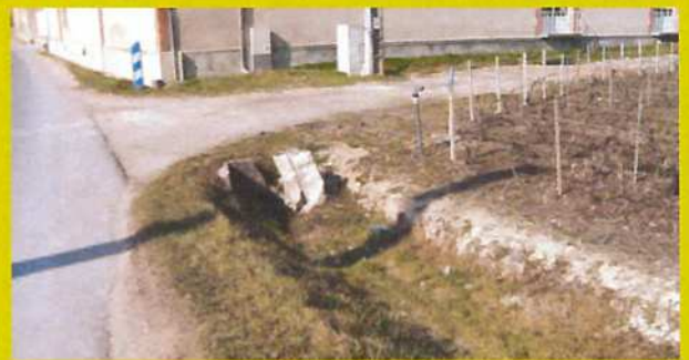
Les fossés enherbés, en bordure de voirie et de vignes, recevant les eaux pluviales avec des éléments structurels peu qualitatifs
