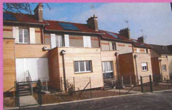
L'intégration de panneaux solaires thermiques sur le versant de toiture, orienté à l'arrière du jardin des maisons
