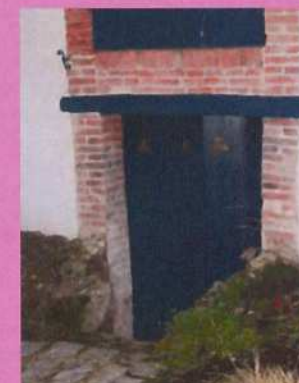
Menuiserie bois de couleur bleu saphir, de la porte de remise, percée d'un trèfle
