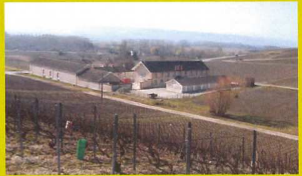
Le vendangeoir Sainte-Hélène situé au sein d'une zone de relief plat, le long de la voie D1 et des versants de vignes.
