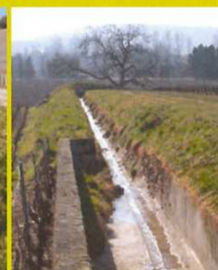
Fossé structuré par des murets de soutènement, aménagé en aval du fossé pour recevoir le cours d'eau dans la plaine
