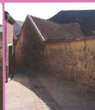
Continuité entre le mur pignon et le mur de clôture, enduits en pierres vues
