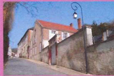
Espace de stockage, inséré derrière les murs de clôture, non visibles depuis la rue
