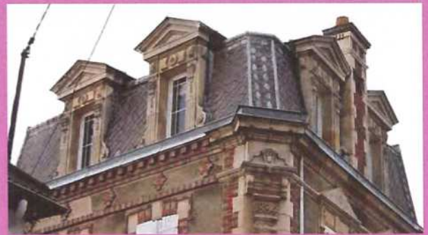
La toiture, composée de cheminées et de lucarnes à façade entière à fronton triangulaire, est réalisée en ardoise en écaille avec une gouttière en zinc, positionnée sur la corniche de briques et de pierre, qui souligne la naissance de celle-ci.
