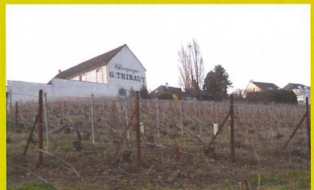
Une greffe urbaine, bâtie en limite du village dans la continuité de l'existant, intègre des espaces liés à l'activité viticole.
