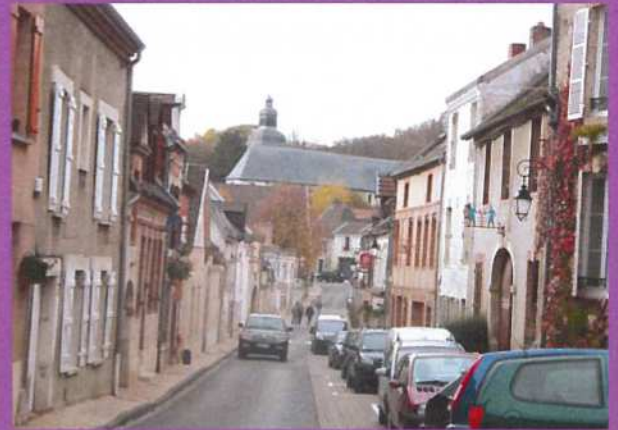
Densité et compacité du tissu générées par l'alignement du bâti sur la voie très étroite sur le parcellaire étroit du centre ancien
