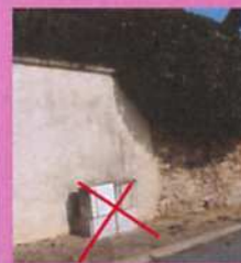
Eviter de disposer les coffrets sur le domaine public, créant un obstacle à la continuité des cheminements piétons, et réaliser un accompagnement paysager réduisant l'impact des éléments techniques
