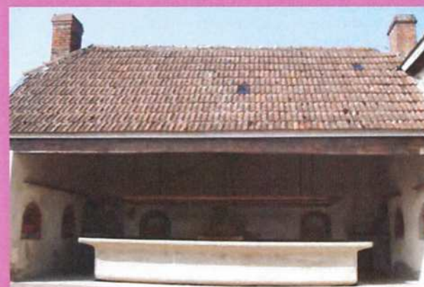
La toiture du lavoir en tuile mécanique et une gouttière, qui longe celle-ci.
