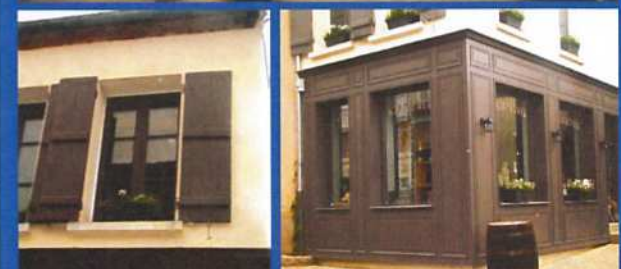
La construction récente au sein du tissu ancien s'intègre parfaitement avec la reprise de la morphologie typique, laissant une percée sur le bâti en fond de parcelle. Le rez-de-chaussée est traité de manière contemporaine comme un soubassement de teinte foncée avec de grandes ouvertures hautes, sans présence de murs fermés : Cette composition illustre le principe de retournement de la façade.
