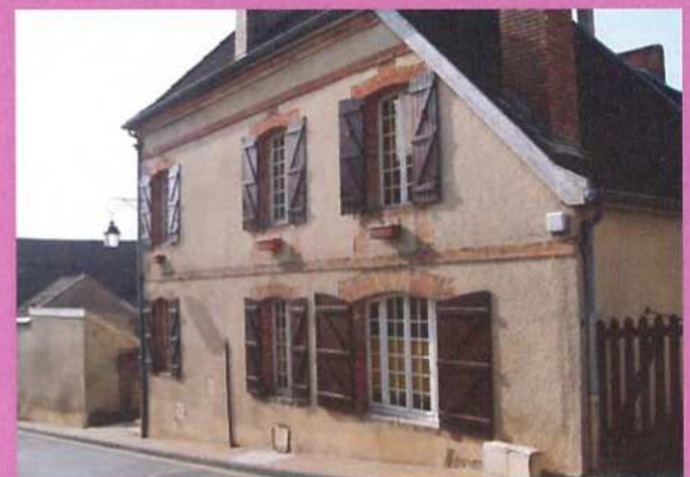
Façade de teinte ocre orangée, caractérisée par des encadrements en brique, associés à des volets bruns foncés
