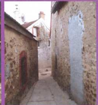
Traitement très minéral et continu entre les murs en pierre et le sol en béton de la ruelle
