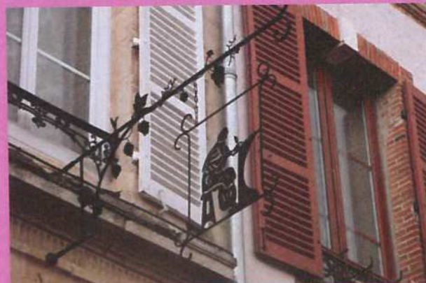
Enseigne en fer forgé de couleur noire, en accroche sur la corniche de pierre, dans l'axe de la porte d'entrée
