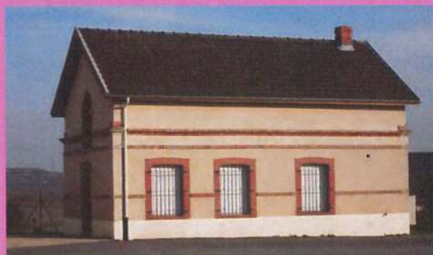
Association des enduits naturels clairs et de la brique en terre cuite (corniche, bandeau, encadrements de baies, cheminée)
