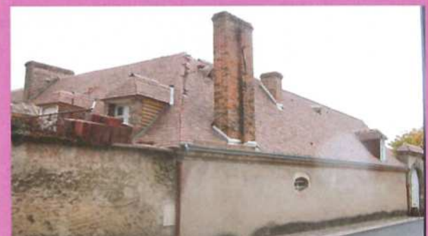
Toiture d'une bâtisse champenoise remarquable en tuiles de terre cuite plates, animée par de hautes cheminées, de lucarnes à croupe et de petites fentes de ventilation
