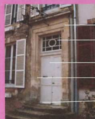
Imposte vitrée et encadrement de pierre remarquable de la porte d'entrée, mise en scène par un long escalier
