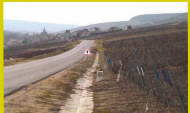
Des aménagements de fossé, à l'image urbaine, pour l'écoulement des eaux, qui sont mal adaptés aux espaces ruraux
