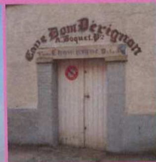
Enseigne peinte sur enduit sur le linteau et au-dessus de la porte de remise
