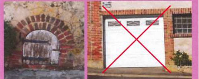
Un étroit percement cintré, protégé par un volet bois épousant la courbure
