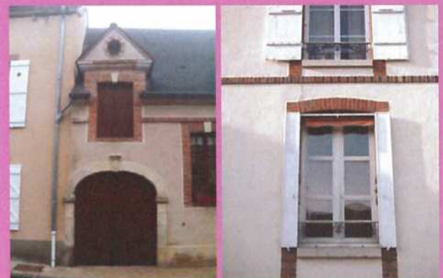
Volets bois peints à persiennes en brun, et porte cochère pleine en lames de bois verticales de même ton
