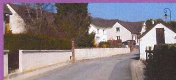
Un traitement sobre des rues dans le tissu diffus : les trottoirs peu larges en béton et en pavés béton de teinte rose sont situés au même niveau que la route.
