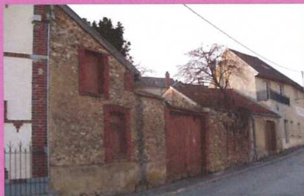
Murs de clôture en pierre en continuité des murs du bâti, composé d'un portail en bois, donnant accès sur la cour intérieure
