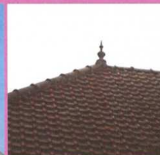
Epi en faitage sur une toiture en tuiles à 4 versants
