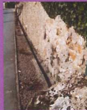
Écoulement des eaux à travers une rigole creusée, le long des murs de clôture
