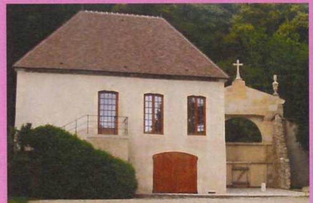
Edifice de l'Abbaye de Saint-Pierre de Hautvillers
