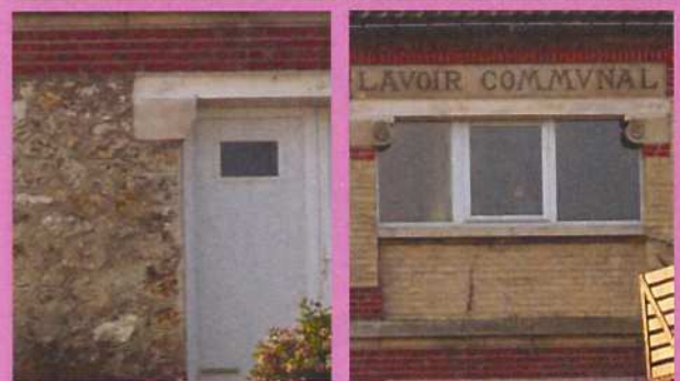
La façade du lavoir communal est composée de plusieurs matériaux et couleurs en briques et en pierre.
