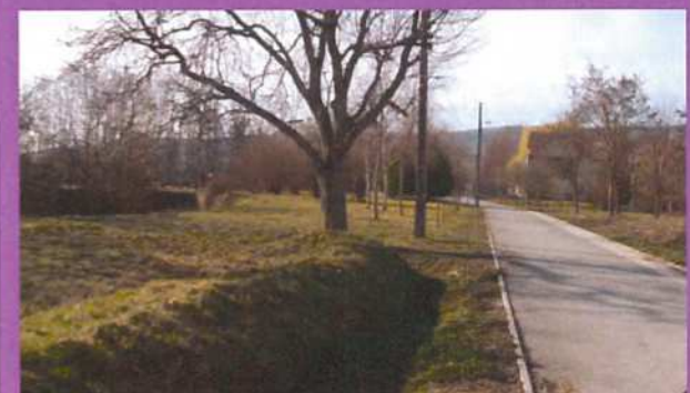
Un fossé enherbé, recueillant les eaux, intégré dans l'espace vert
