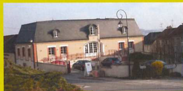
L'extension de la coopérative, à l'architecture classique, présente un traitement très minéral de ces espaces libres avec une aire réservée aux stationnements, qui est ceinturée par une clôture en maçonnerie enduite, structurant le croisement des voies.
