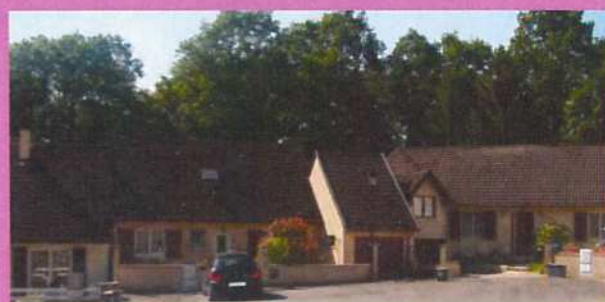
Une même typologie de toitures en tuile mécanique de fibrociment au sein du tissu récent du Prés Jaumés, caractérisée par deux longs versants pentus, qui marquent le paysage
