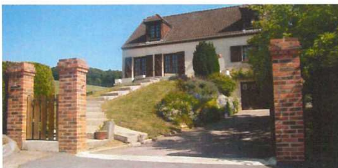
Intégration d'un garage dans la construction avec un aspect massif du volume
