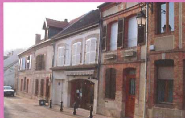
Façades, structurées par un rythme soutenu de travées, composées de percements avec des encadrements de briques très variés
