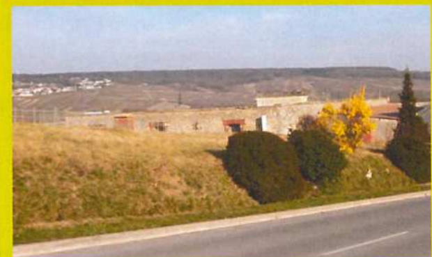
Le bâtiment très étendu à toiture plate a un très faible impact paysager.
