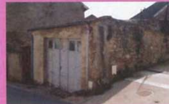
Usage du Bâti ancien peu entretenu, reconverti en garage
