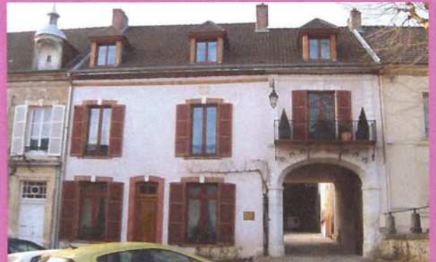
Plusieurs types de percements_ porte d'entrée, porte cochère, fenêtres_ sont organisés à partir de trois travées avec une légère asymétrie, créée par le positionnement de la porte.
