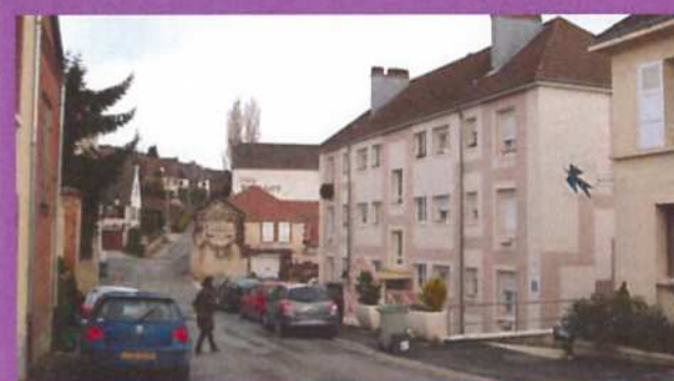
Une implantation en rupture du tissu d'un immeuble « plot » de 3 niveaux au cœur d'une parcelle, située en angle de rue
