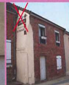
Pré-enseigne, située sur un mur pignon à éviter
