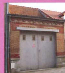
Façade ornementée, préservée lors du changement de vocation du bâti en garage
