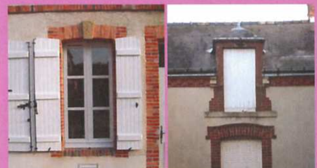
Volets bois à planches, peintes en blanc, soutenues par 3 traverses / volets à persiennes métalliques
