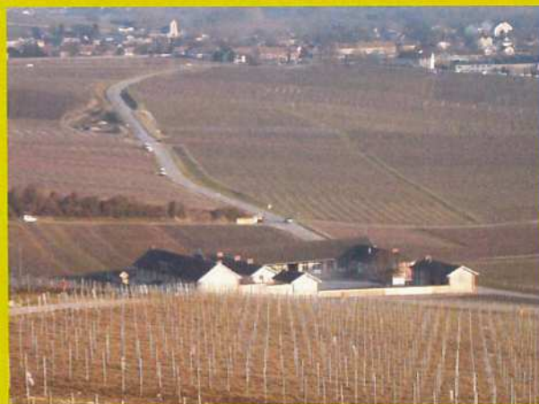
Les différents grands bâtiments, agencés autour d'une grande cour, composent le vendangeoir Sainte-Hélène. Ils longent l'une des sources d'eau qui s'écoule vers la Marne.
