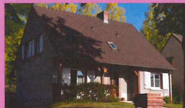
Percements encadrés de brique d'un pavillon récent au sein du tissu récent, inspirés des composantes locales de Hautvillers
