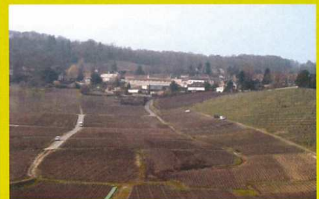
Les limites bâties du village groupé, laissant les grandes étendues de vignes, tramées par les chemins de craie
