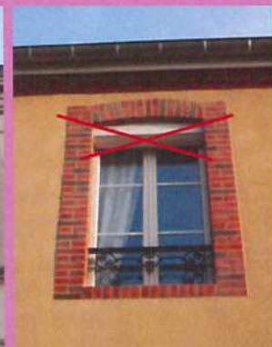
Intégration d'un volet roulant, positionné à l'extérieur de la baie, qui occulte une partie de la lumière
