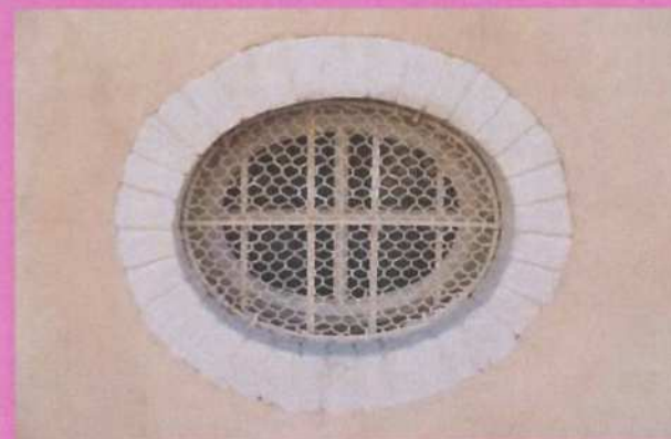
Briques, ferronneries et menuiseries de teinte blanche très claire, en harmonie avec l'enduit beige
