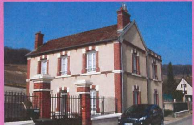
Volume souligné par des encadrements de briques, associés à de la pierre, sur un mur enduit avec un jeu de couleurs en façade
