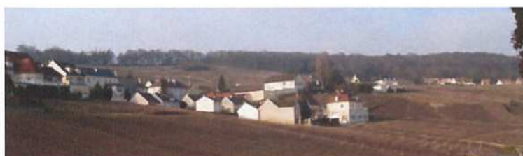
Les limites bâties franches du village sans accompagnement paysager et sans insertion dans le site avec le fort impact des nombreux murs pignons
