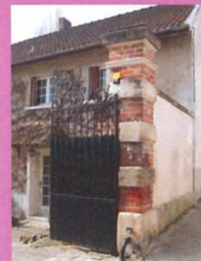
Appareillage de brique et de pierre pour des piliers du portail
