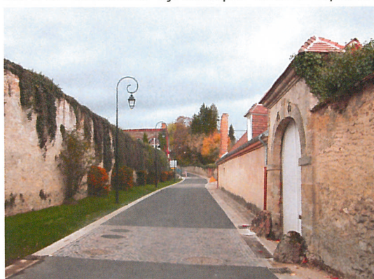
Route de Cumières – entrée de village Ouest, très structurée par les murs en pierres anciennes de hauteur homogène L'association du minéral et du végétal
