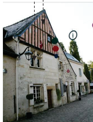
Fenêtre en croisée Colombage
