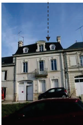
Toit à la mansart
