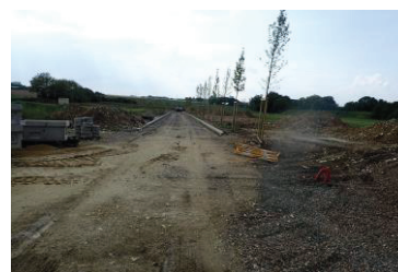
Photo 15. Zone rudérale (travaux)
