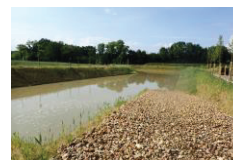
Photo 17. Bassin de rétention d'eau
