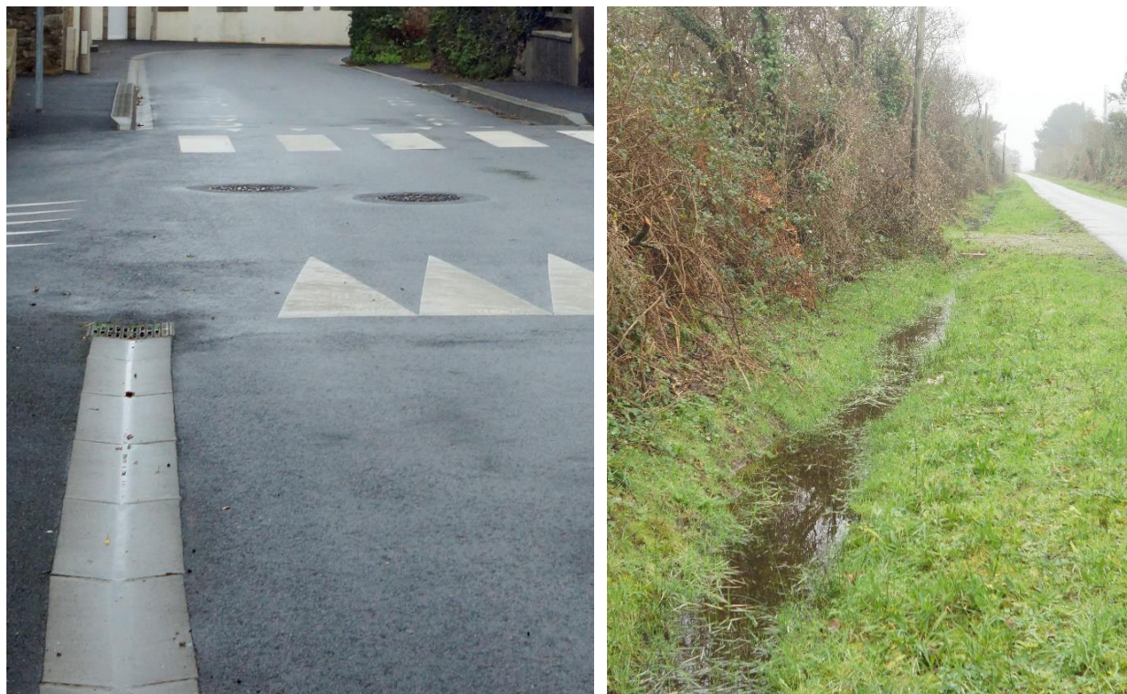
Assainissement souterrain sur le bourg de Landunvez (à gauche) et assainissement aérien dans la partie agricole (à droite)
