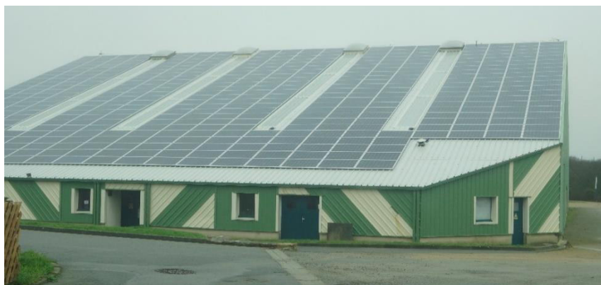
Installation photovoltaïque sur le gymnase
