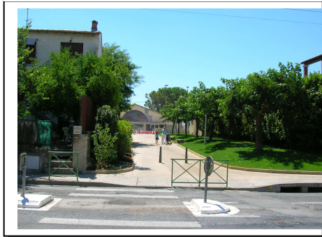
L'allée de l'honneur après aménagement
