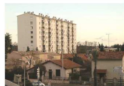
Quartier de Galine, composé de formes d'habitat diverses (collectifs, individuels groupés, individuels)
