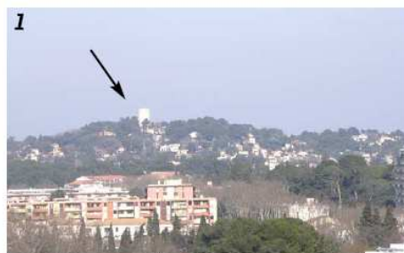
Colline de Substantion, marquée par le château d'eau, point dominant du territoire perceptible depuis Montpellier (Le Corum)
