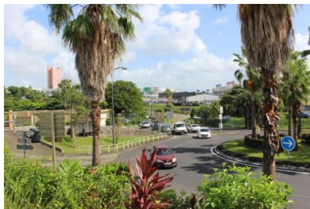
Figure 32 : Entrée de ville à la Bafelière sur la RN2 // crédit CITADIA
