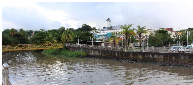
Figure 44 : Berges artificialisées dans le secteur Anse Madame, à l'embouchure de la rivière Case Navire // Source : CITADIA
