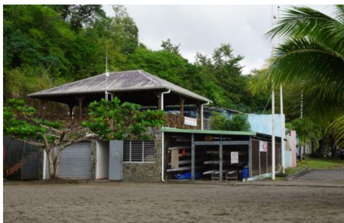
Figure 155 : Unique structure (Restaurant et équipements nautiques) sur la plage de Madiana à renforcer à l'avenir // crédit CITADIA
