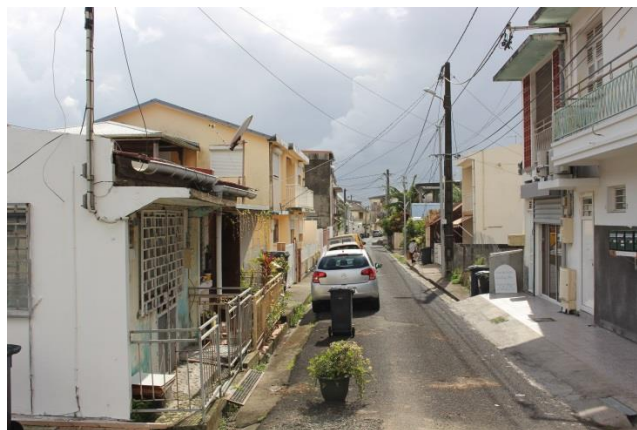
Voirie inadaptée à réaménager et sécuriser // Source : crédit CITADIA
