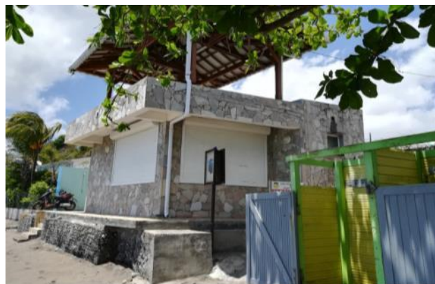
Figure 160 : Centre de surveillance fermé à l'Anse Madame // crédit CITADIA
