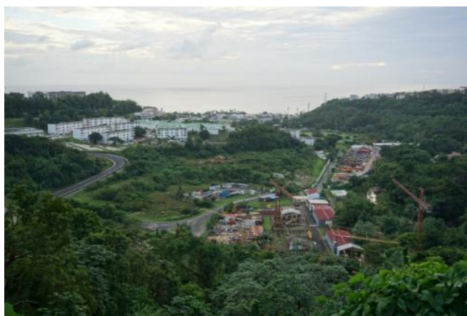
Vue sur la ravine de Case Navire et les activités qui y sont implantées
