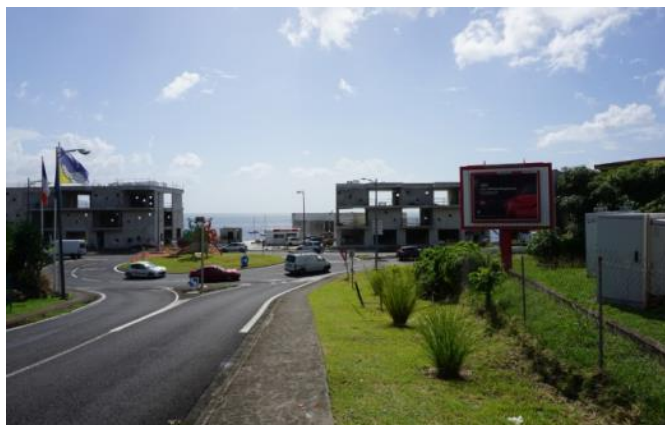
Constructions le long de la RN2 à Anse Gouraud
