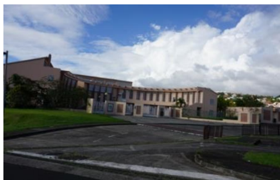
Figure 100 : Lycée de Terreville à Terreville // crédit CITADIA
