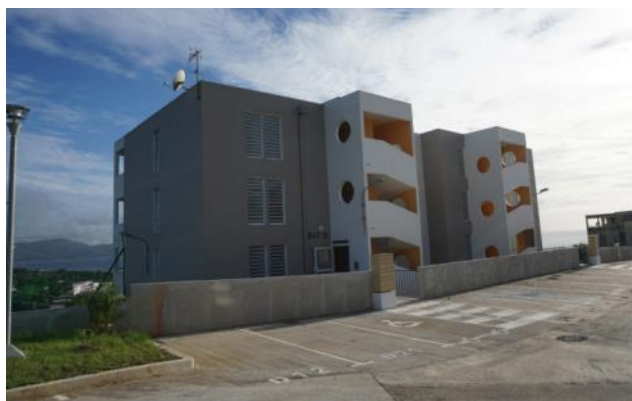
Figure 84 : Logements sociaux quartier Enclos // Source : crédit CITADIA
