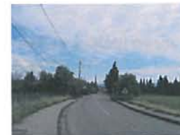
Route de la gare- entrée de ville nord depuis Aubignan
