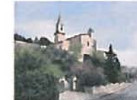
Talus végétalisé en pied d'Eglise
