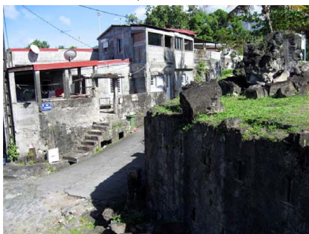
Bâti dégradé à côté des ruines de l'Eglise du Fort
