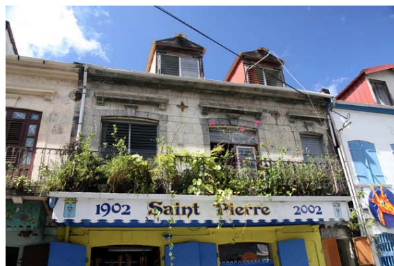
Maison de ville (rue Gabriel Péri) Vue des ouvertures
