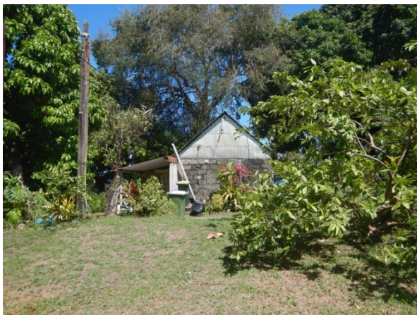
Maison à démolir et reconstruire (vue depuis l'impasse)
