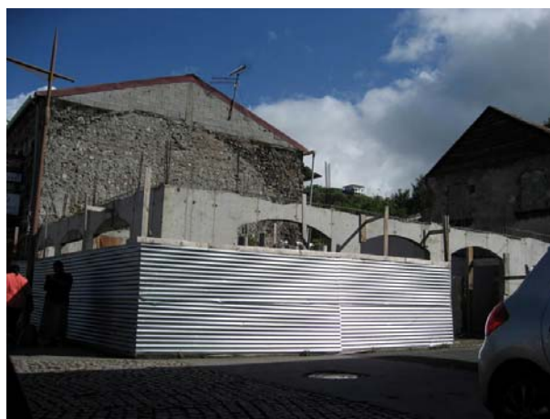
Construction inachevée en centre ville
