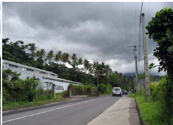
Bâtiments abandonnés le long de la RD10
