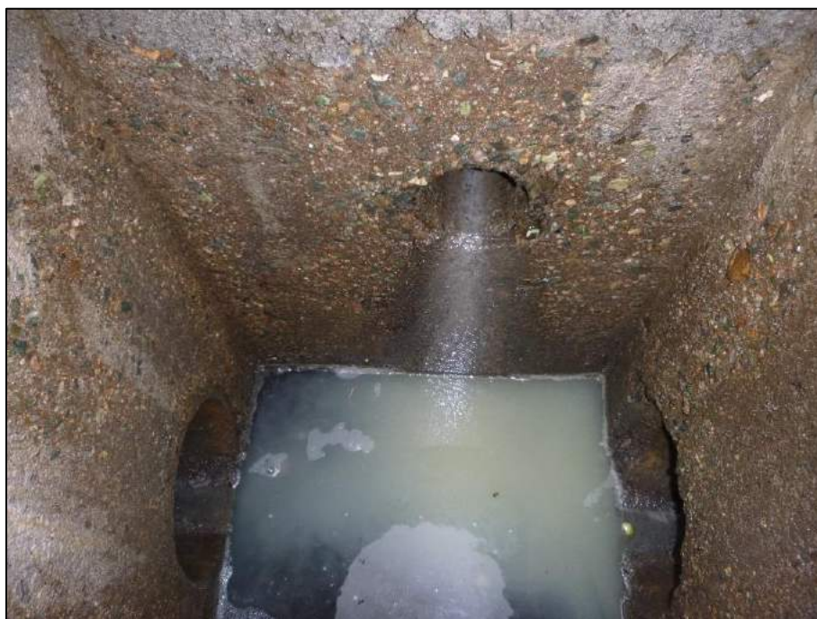
Photo 6 : Vue d'un rejet d'eaux vannes – Rue du 19 Mars 1962
