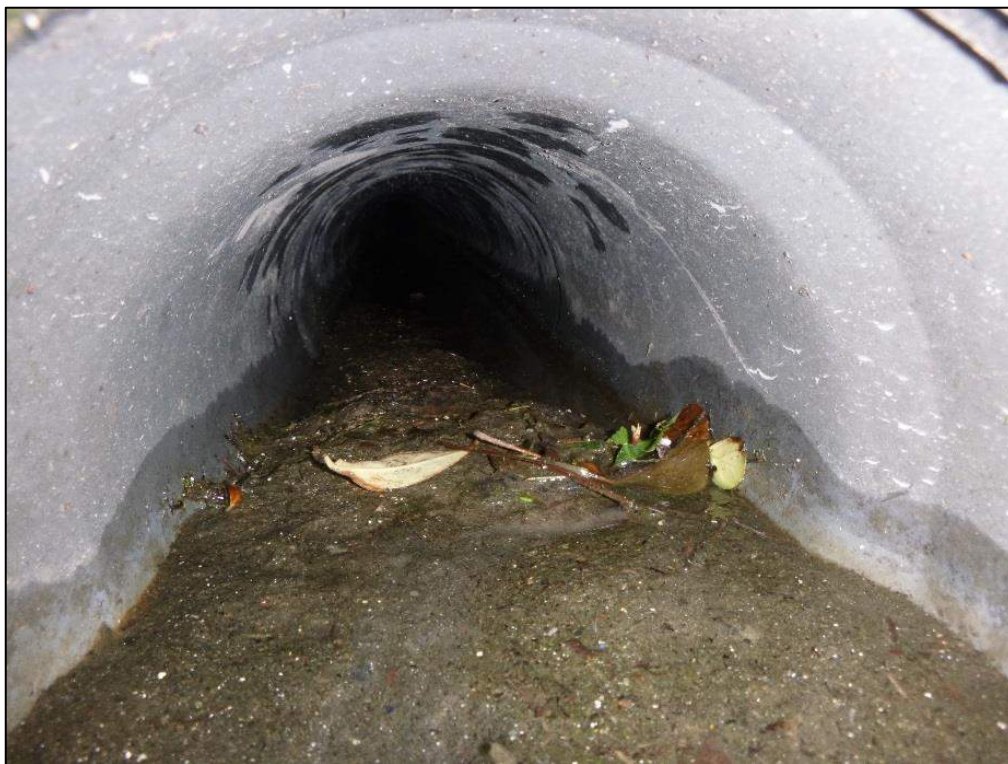
Photo 2 : Vue d'un réseau à curer – Rue Hent Saint Gonery (Ø250)
