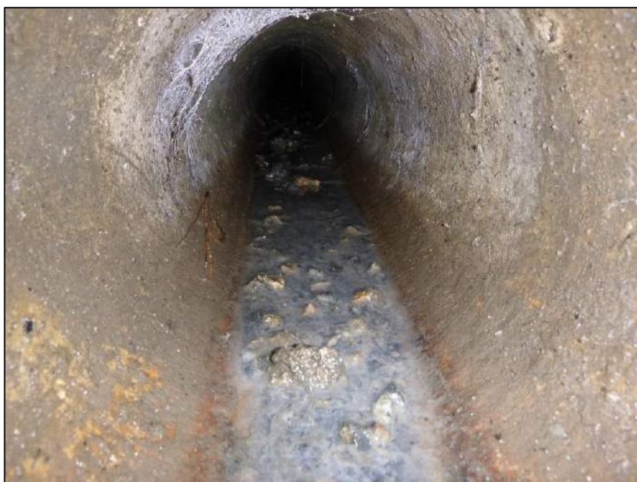
Photo 7 : Vue d'un mauvais rejet type eaux vannes – Rue du 19 Mars 1962
