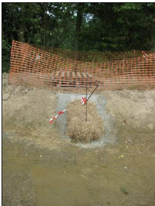
Photo 10 : Emplacement du filtre à particules fines (botte de paille) pendant la phase des travaux au niveau du bassin d'orage
