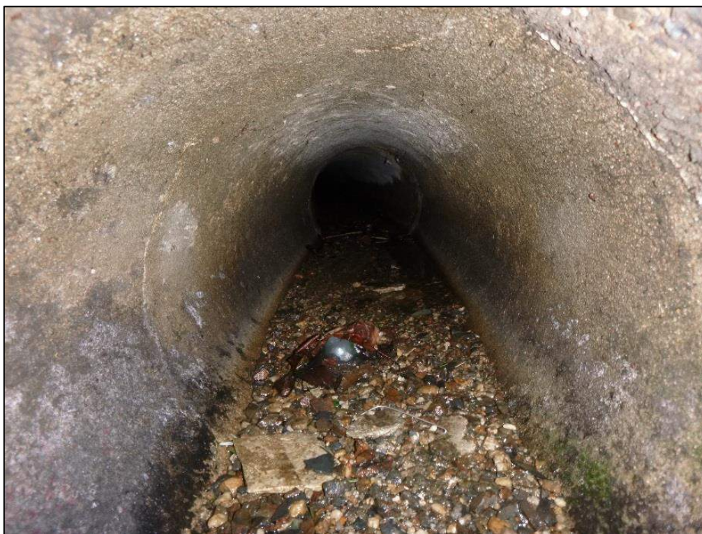
Photo 3 : Vue d'un réseau à curer – Place de la Mairie (Ø300)
