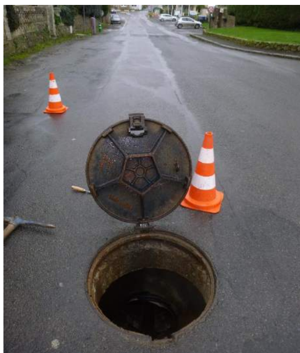
Photo 1 : Vue d'un regard de visite eaux pluviales ouvert durant la phase terrain
