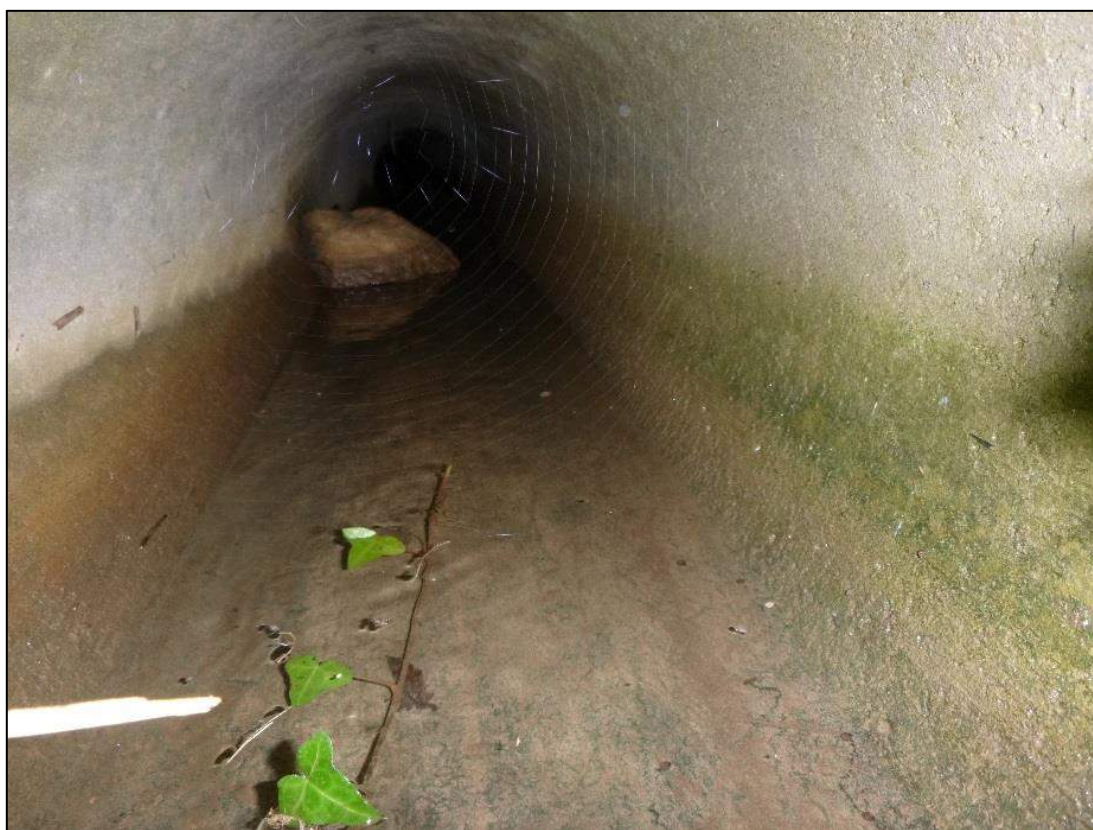
Photo 8 : Obstacle à l'écoulement – Réseau Ø400
