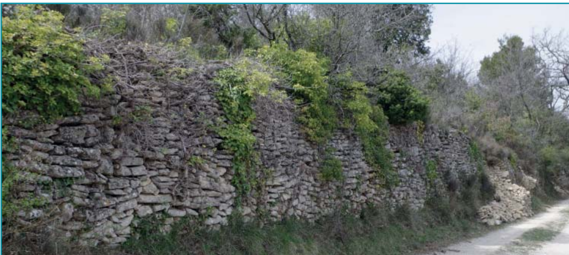
Exemple de mur de pierres sèches constituant un abri pour les reptiles
