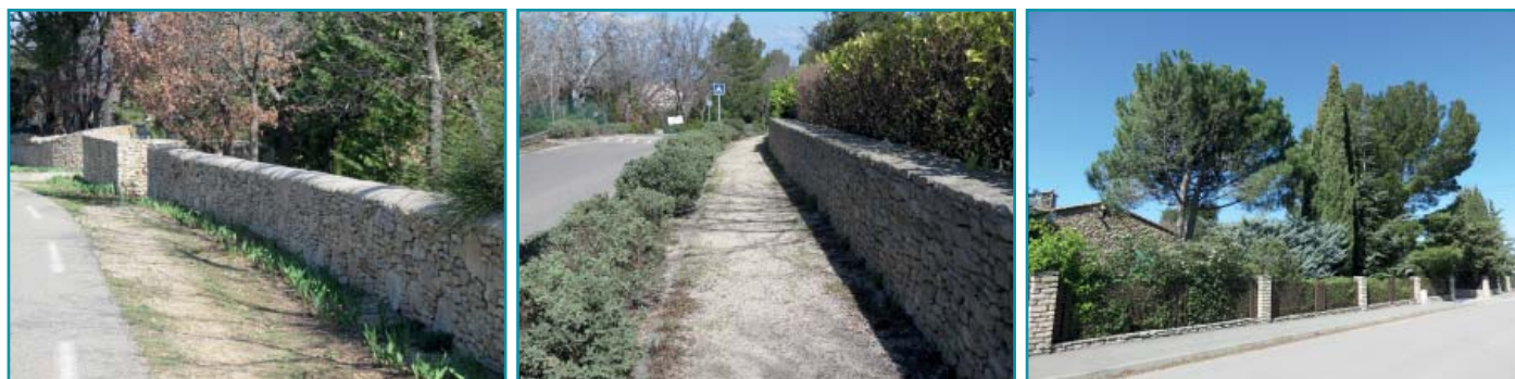
Déplacements piétonniers fragmentés le long des RD 57 et RD 210
