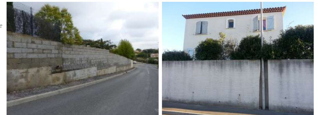
Fermeture visuelle par des murs de clôtures trop hauts
