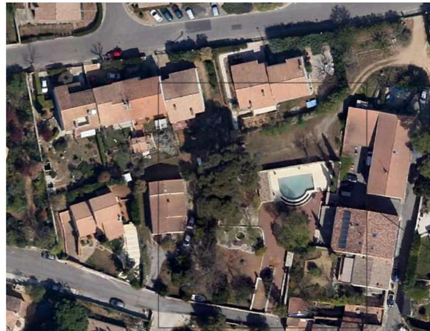
Existant - source : google earth
