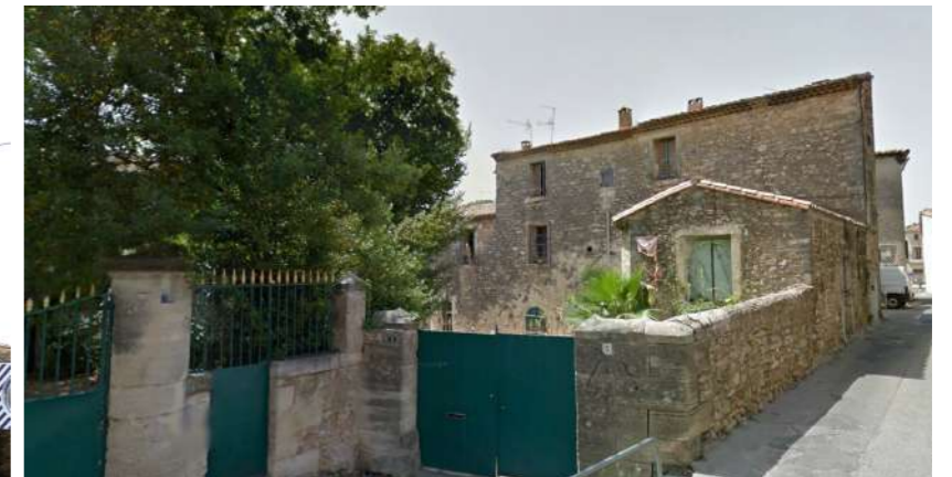
Ancienne ferme des Barris jouxtant le centre ancien
