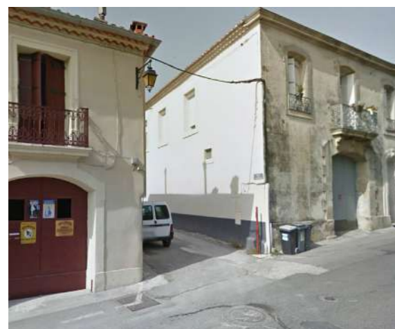
Fronts urbains des faubourgs XIX e , rythmés par les portes charretières, les baies et leurs balcons, les bandeaux et les
