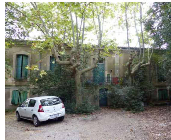
Vue depuis l'entrée
