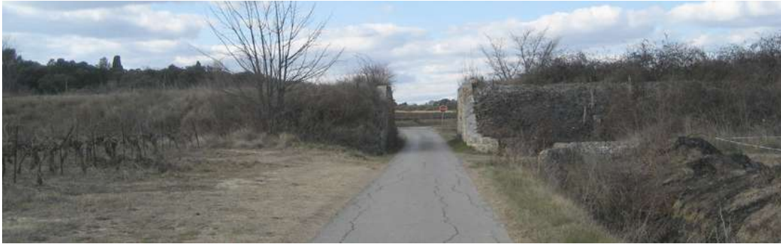
pont sous voie ferrée
