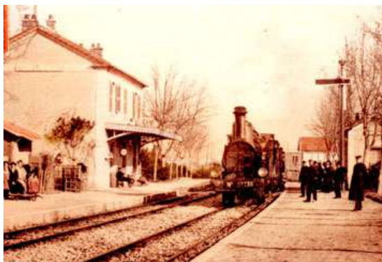
la gare en fonctionnement
