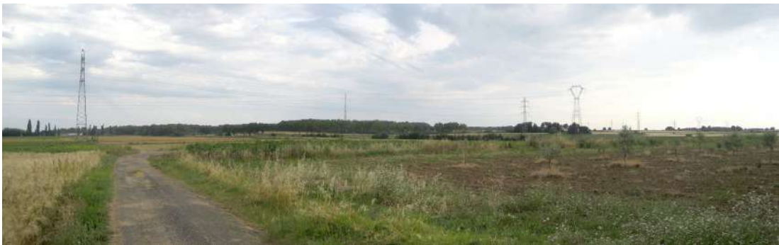
ligne haute tension
