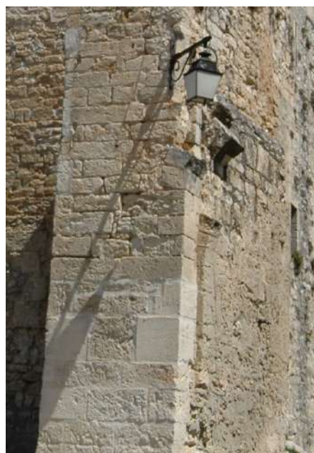
détail vestige porte Ouest
