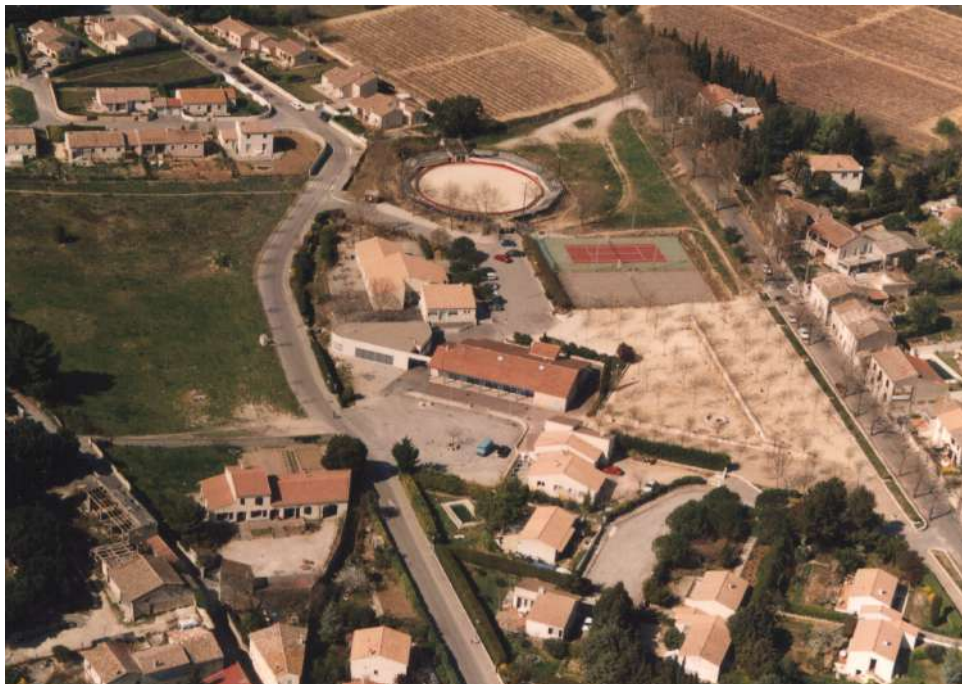
les équipements publics et la voie de liaison, vue aérienne vers l'Ouest
