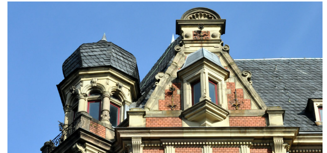
Couverture en ardoises «pose vieilles allemandes» sur une toiture de la fin du XIX e siècle © Région Grand-Est - Inventaire général
