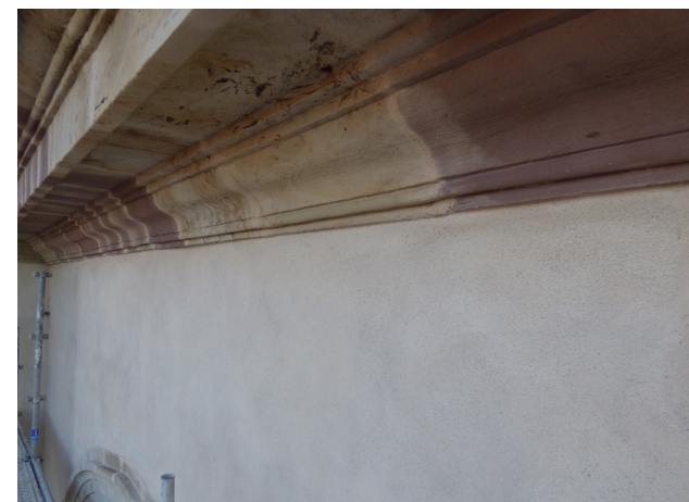
Réfection d'un enduit au mortier au chaux © Atelier G. André
