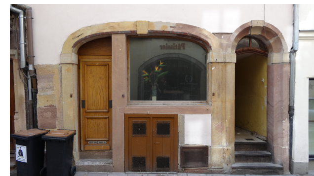
Baies d'échoppe dont les aménagements ont contribué à faire disparaître ses caractéristiques typologiques et sa valeur patrimoniale ©Atelier G. André
