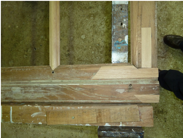
Greffes et restitution de petits bois sur une menuiserie XVIII e siècle © Atelier G. André
