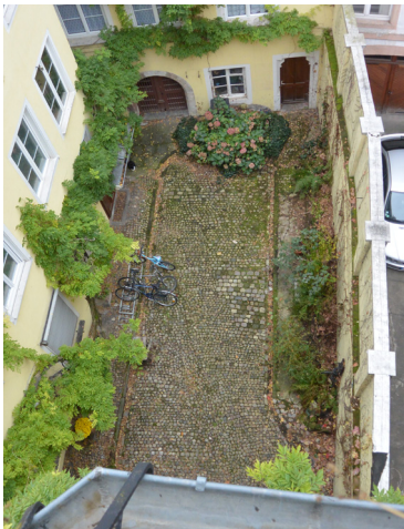
L'aménagement perméable du sol (galets du Rhin) et la végétalisation verticale et en plates bandes périphériques contribuent à la qualité du cadre de vie ©Bailly-Leblanc
