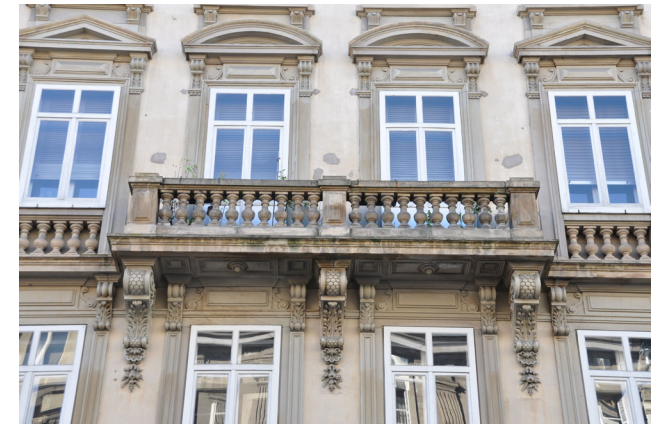
Doubles menuiseries extérieures d'origine sur un immeuble de la Neustadt. Leur dessin à traverse et imposte respecte celui de la menuiserie intérieure © Région Grand-Est - Inventaire général
