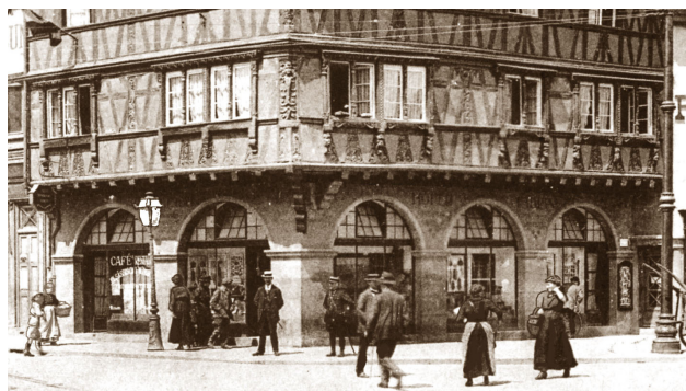
Baies d'échoppe au RDC d'un immeuble en pan de bois du XVIII e siècle, réaménagées au XIX e siècle ©AVES
