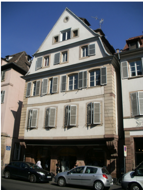
Façade du XVIII e siècle : valeur de typologie architecturale, génie constructif, de d'ancienneté, d'authenticité et d'intégrité © Bailly-Leblanc
