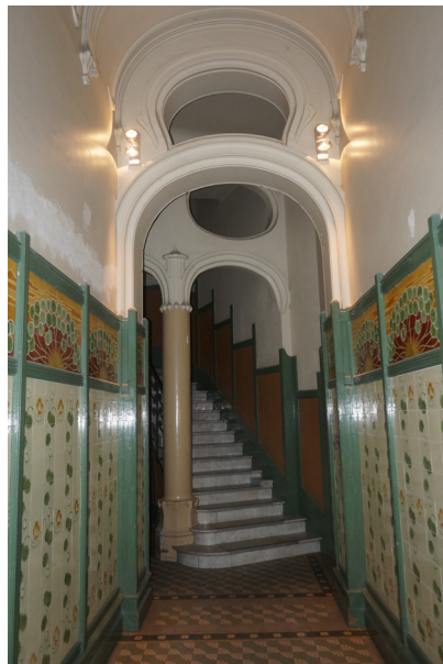
Vestibule Art Nouveau : valeur de génie constructif, de créativité artistique, d'authenticité et d'intégrité © Atelier G. André
