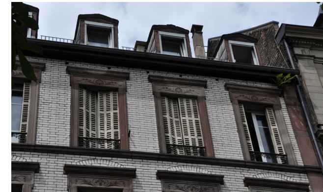
Volets en bois articulés et persiennés se repliant dans l'épaisseur de l'encadrement - fin du XIX e siècle © Région Grand-Est - Inventaire général
