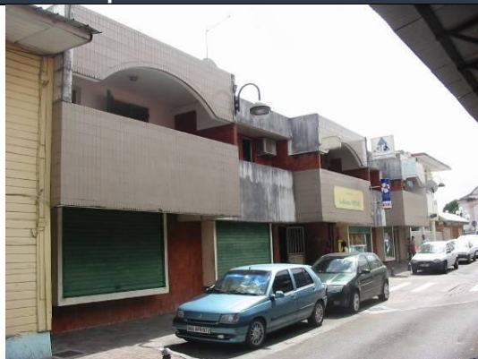
Immeuble Guillaume Mesnil Rue Jules Ferry
