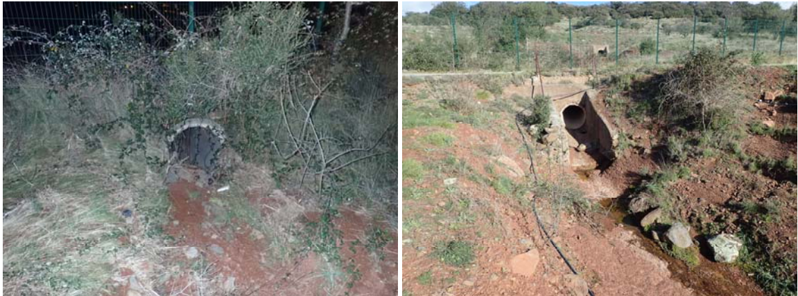
Figure 20 : Vues amont / aval de l'OH10
