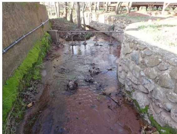
Figure 29 : Vue amont de l'OH26
