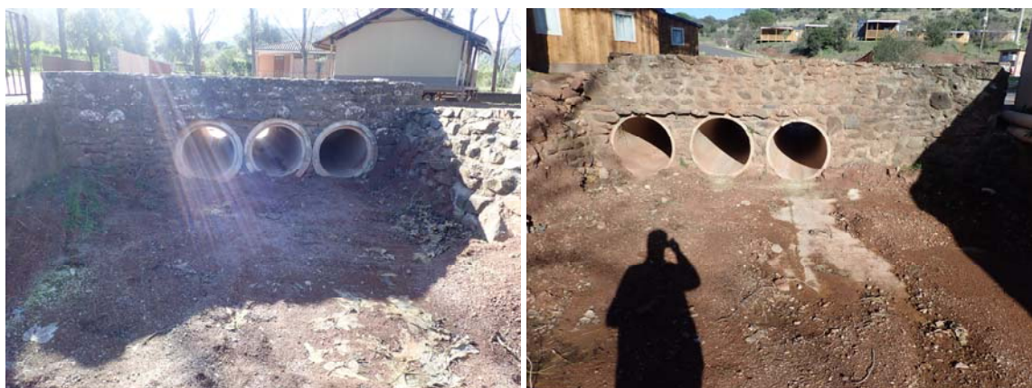
Figure 23 : Vues amont / aval de l'OH11
