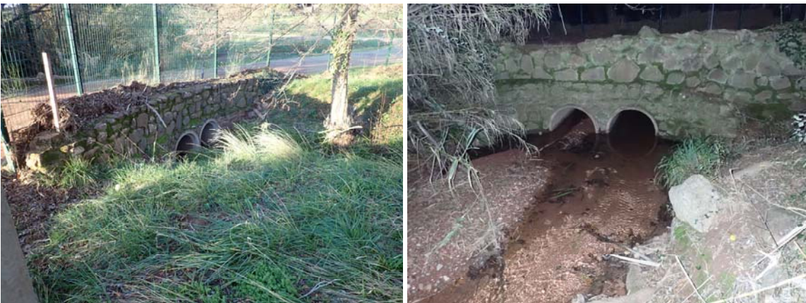
Figure 31 : Vues amont / aval de l'OH16
