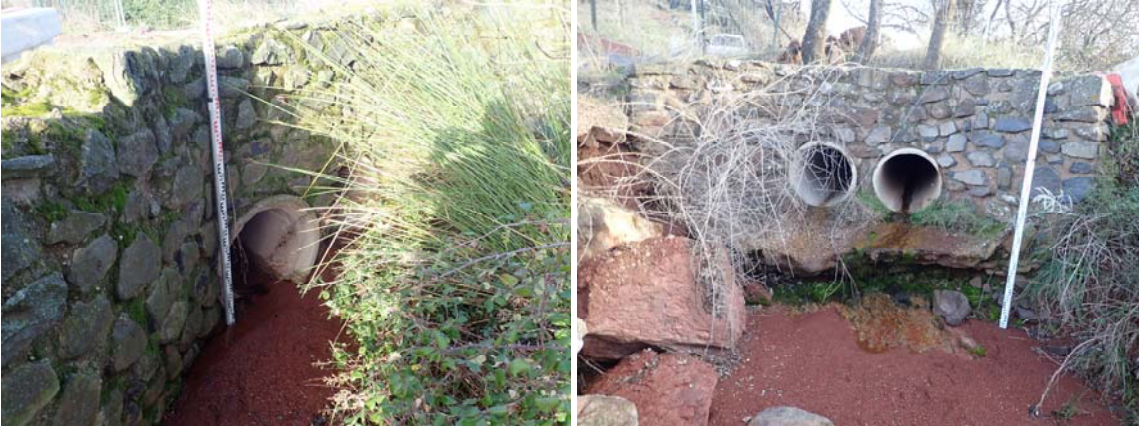
Figure 18 : Vues amont / aval de l'OH02
