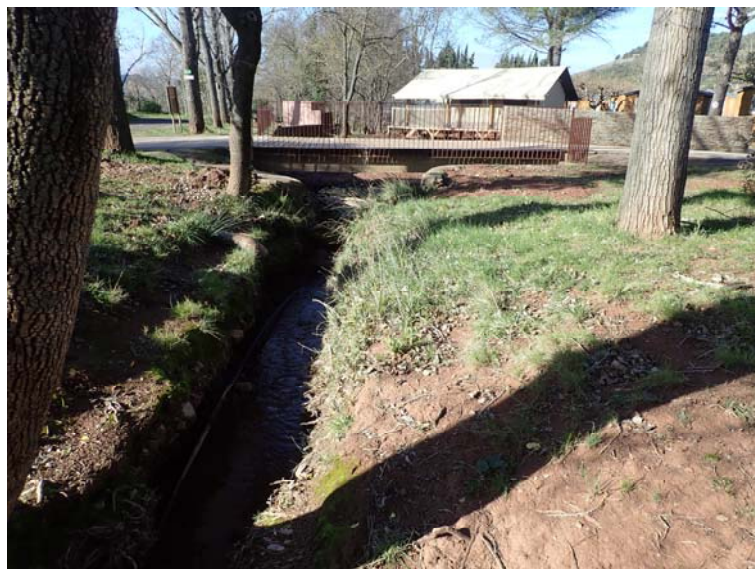
Figure 10 : Pont en bois en amont en amont de la confluence avec l'affluent 3
