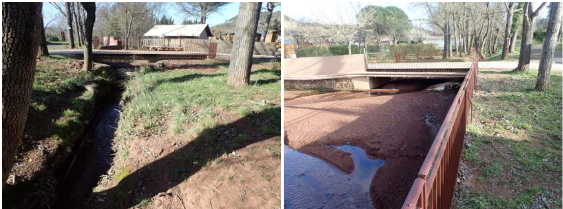
Figure 28 : Vues amont / aval de l'OH12
