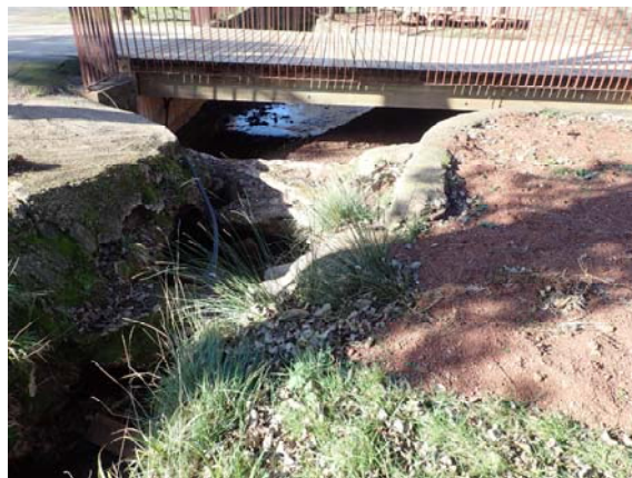
Figure 27 : Vue amont de l'OH27
