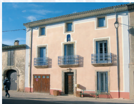
Réhabilitation à Salasc
