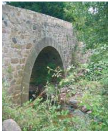
Pont sur le ruisseau Lignous, au niveau de Malavielle
