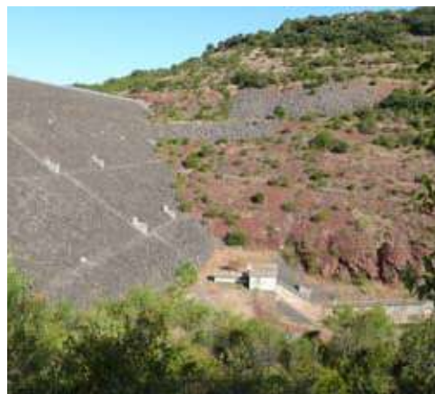
L'arrière du barrage, construit en pierre basaltique
