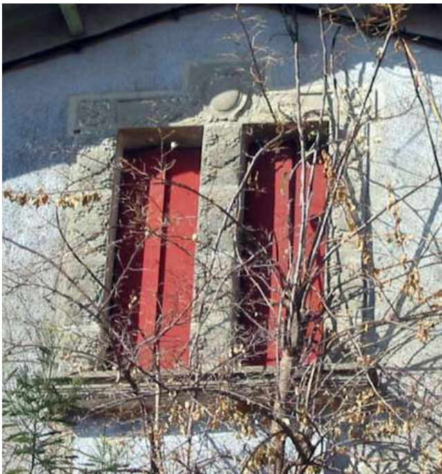
Une maçonnerie en blocs de pierre encadre cette fenêtre à meneaux.
