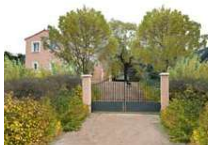
Cette simulation montre tout l'intérêt d'un aménagement végétal du terrain, de son entrée et de ses limites, qui contribuerait à intégrer le bâtiment dans son site.
