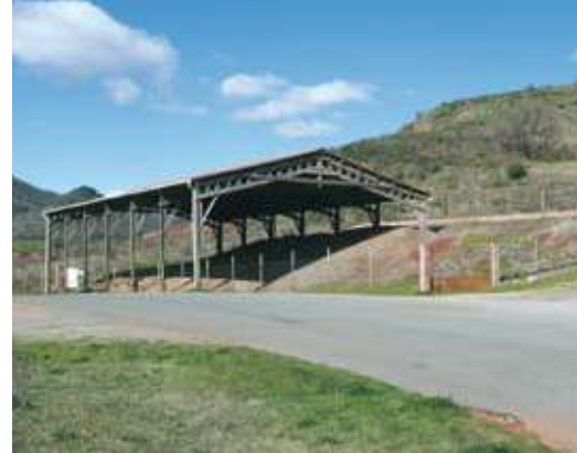
La halle de la Lieude, sa charpente en treillis de bois et sa toiture parallèle à la voie et aux pentes du relief.
