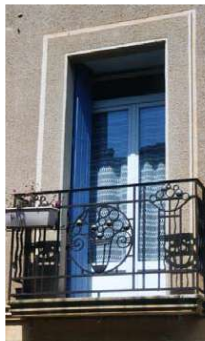
Ferronneries travaillées pour les garde-corps des balcons
