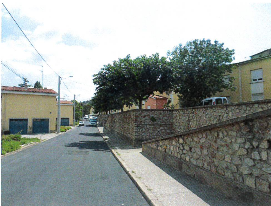
Photo 17 – rue Convention – la forme urbaine distingue tout en les reliant les flux automobiles et les espaces publics pour piétons en terrasse et en pieds d'immeubles.
