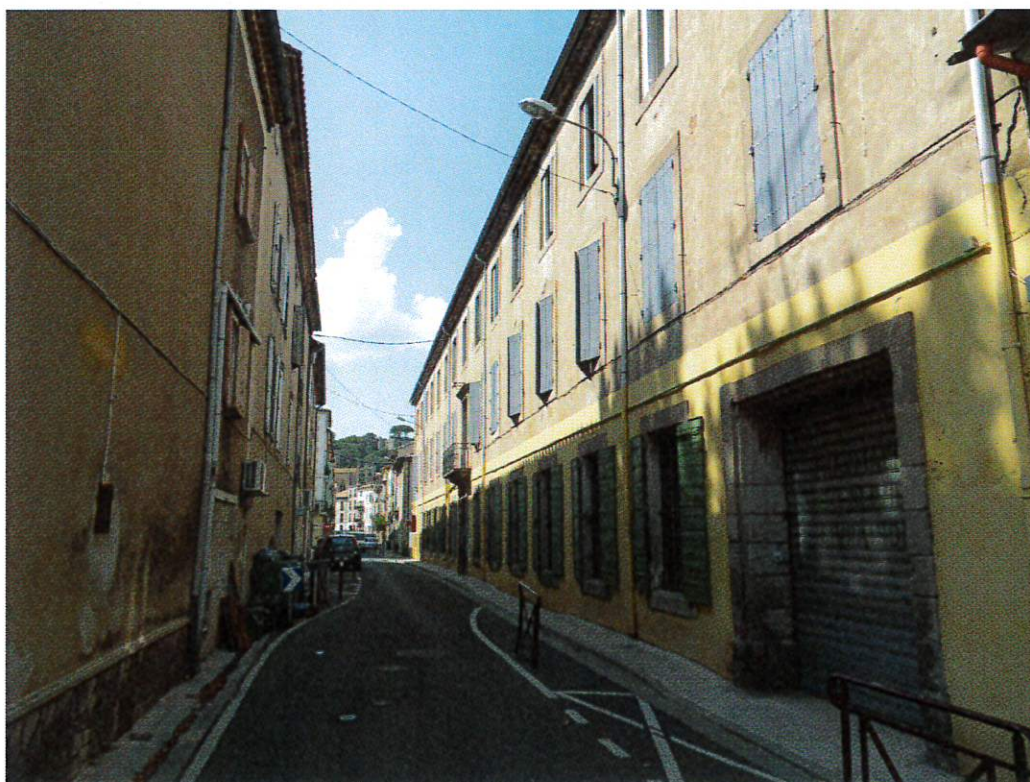
Photo 16 – Alignement remarquable rue Rouquette concordant à un ensemble construit lors des extensions du XIXe siècle. A l'arrière plan, le puech Castel termine et enjolive la séquence relativement austère.
