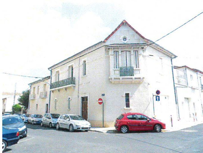
Villa de la première partie du XXe siècle (photo 30)
