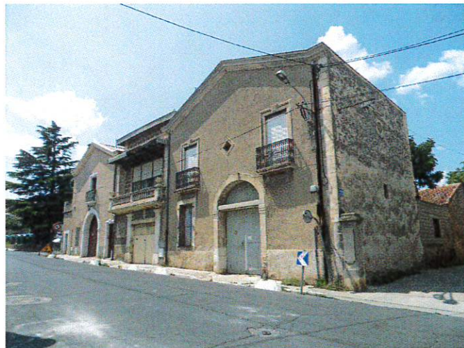
Bâti de faubourg de type vigneron (photo 31 à 33)
