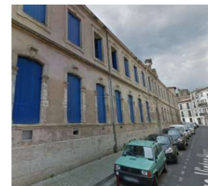
3. Lycée René Gosse, partie ancienne
