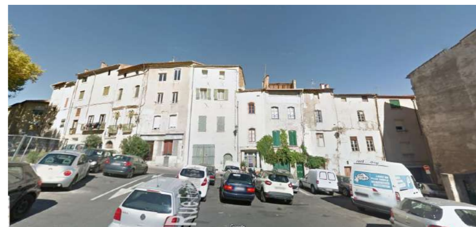
2. Bâti vue depuis l'îlot Enoz
