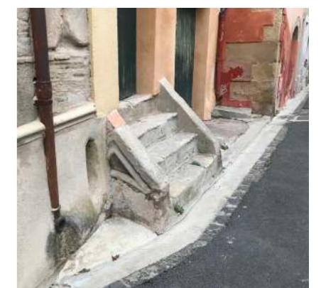
4. Ré-emploi dans le bâti, escalier
