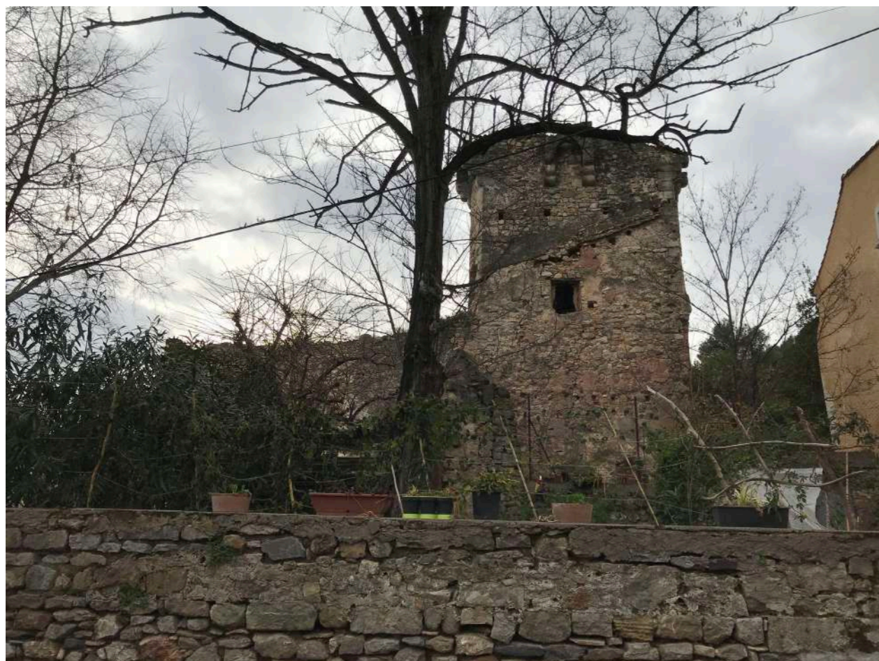
Ruine de la tour Bashole, rue Malbourguet
