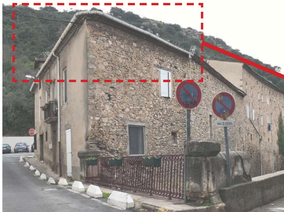
Gouttières contemporaines standardisées
