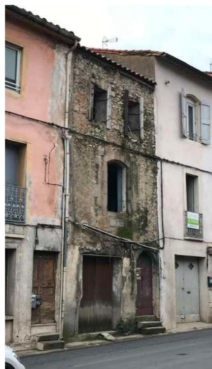
Bâtiment rue de la Coutellerie
