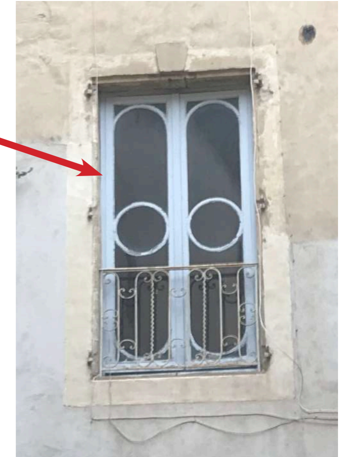
Exemple de fenêtre ancienne avec menuiseries en bois
