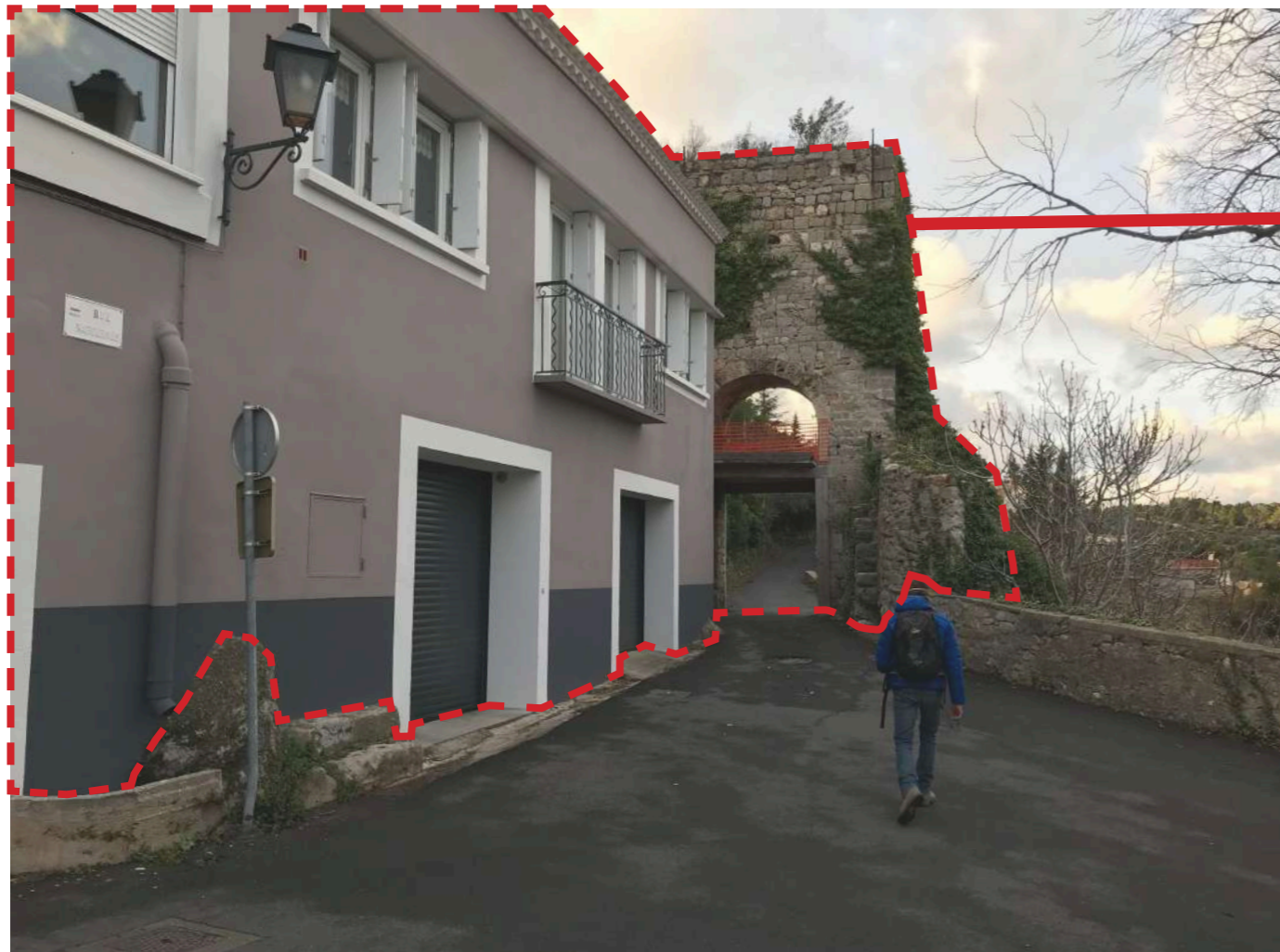
Gris faisant trop ressortir la construction neuve par rapport à celle du rempart (effet d'écrasement visuel)
