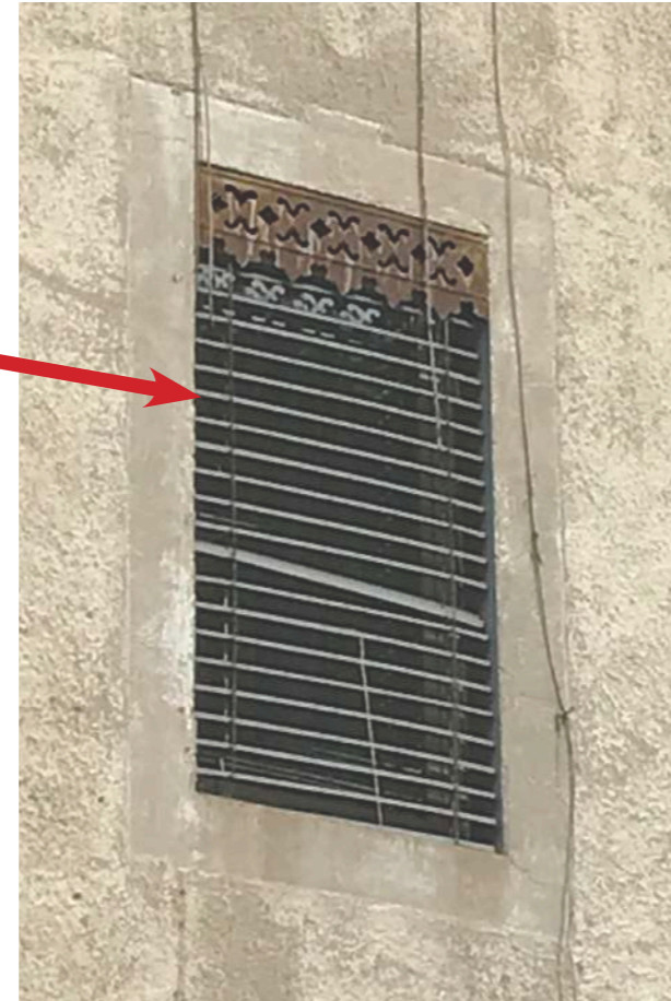
Exemple d'un vestige de store en bois et à lambrequin du XIXe s.
