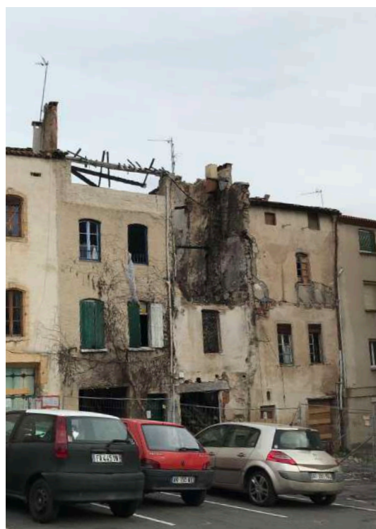
Front bâti vue de l'îlot Enoz
