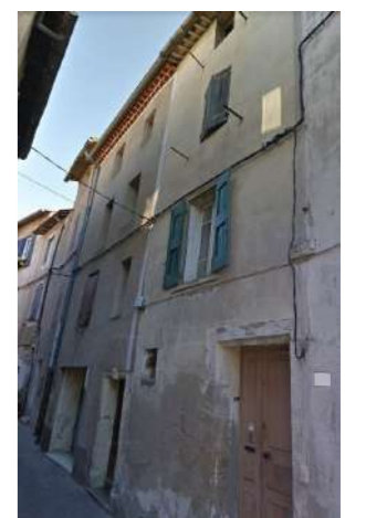
3. Bâti rue Filandière
