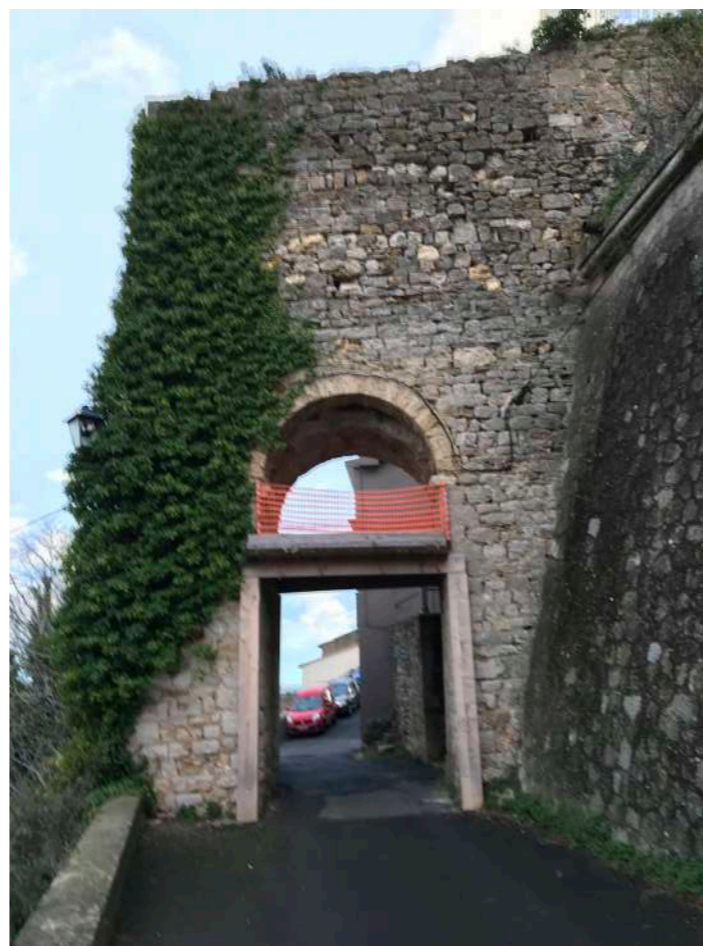
Ruine du Portal Naou, rue du Portal Naou
