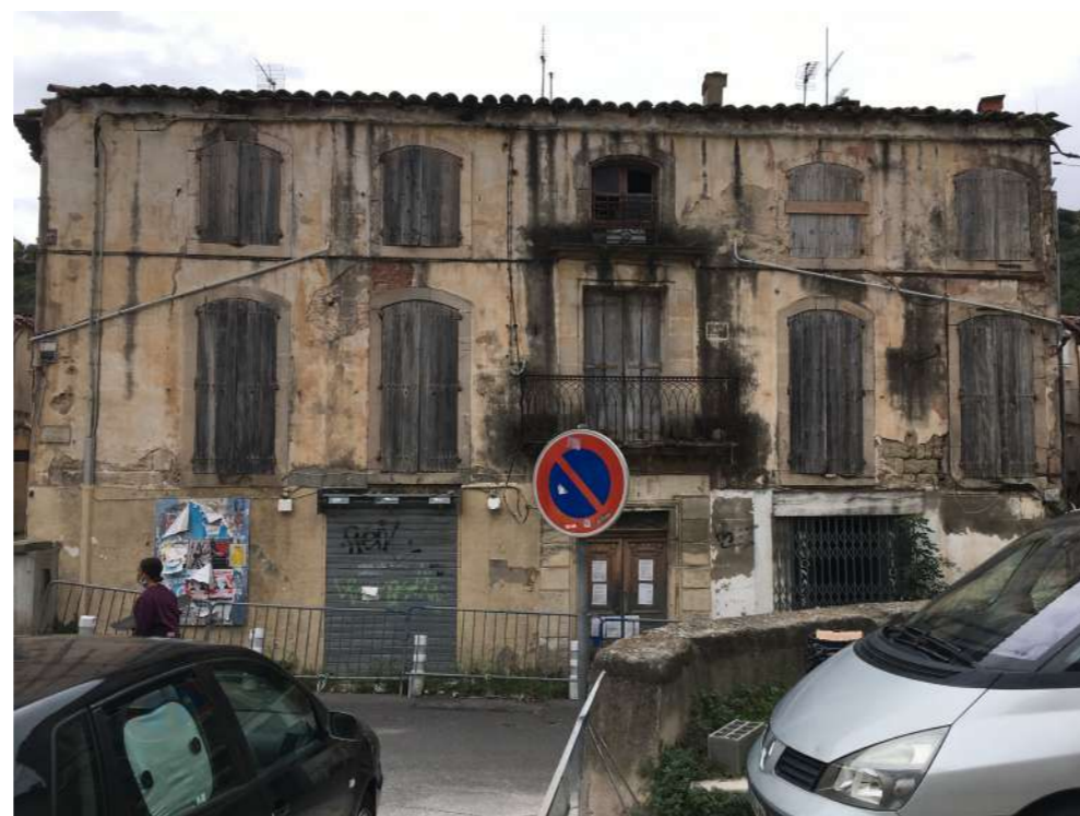
Bâtiment place St Paul
