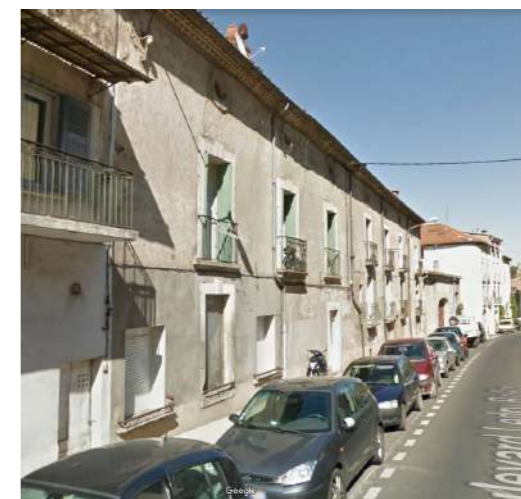
3. Maisons groupées, boulevard Ledru Rollin
