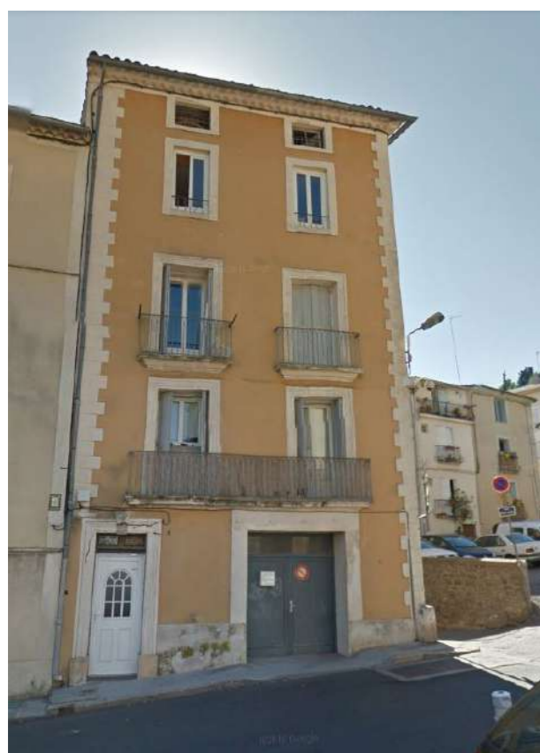
Immeuble rue du Marché
