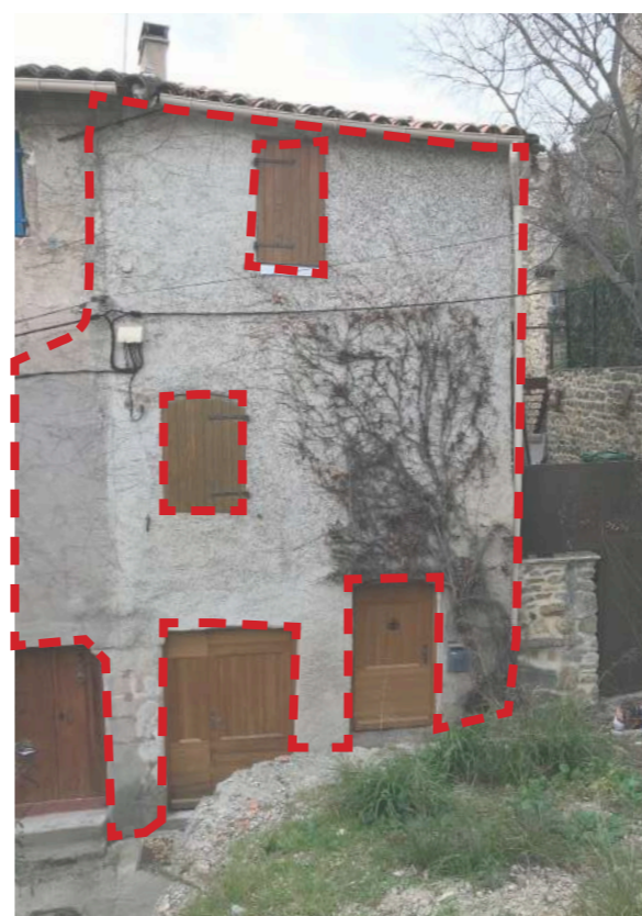
Enduit contemporain peu adapté et imitant un enduit traditionnel, rue Malbourguet
