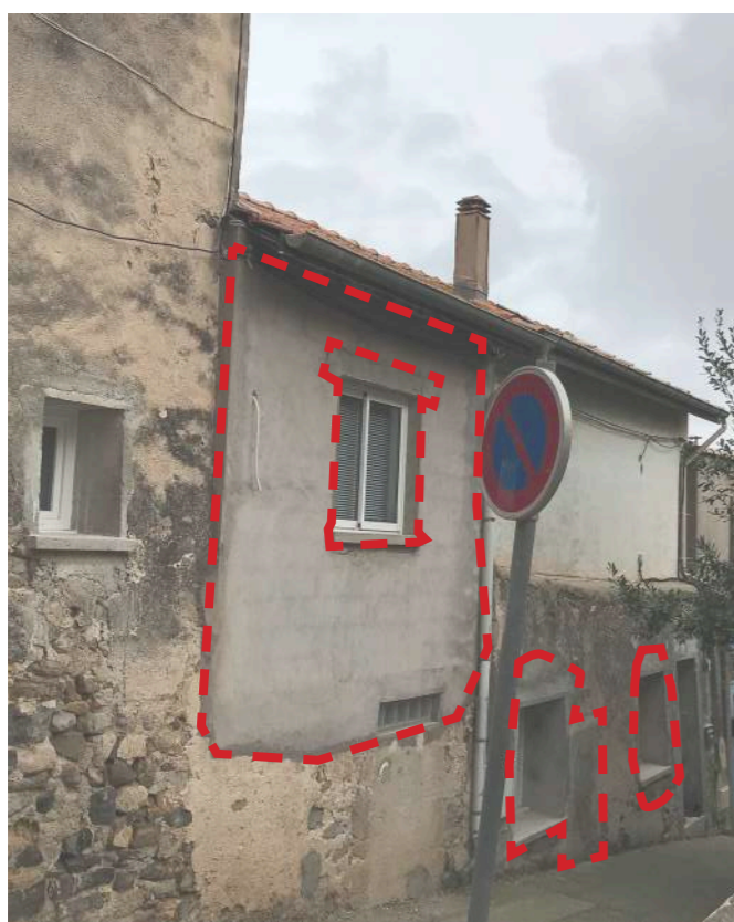
Reprise d'enduit en ciment, rue de la Concorde
