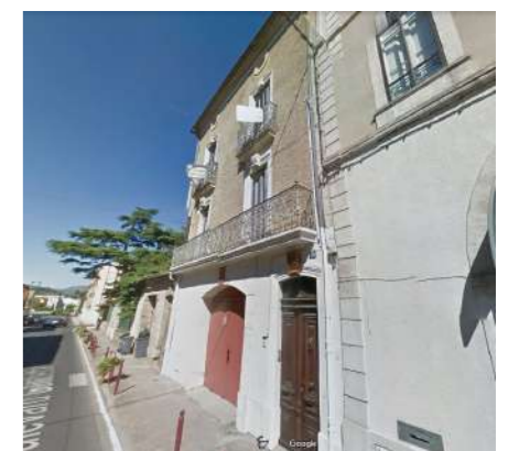
3. Bâti du boulevard Gambetta
