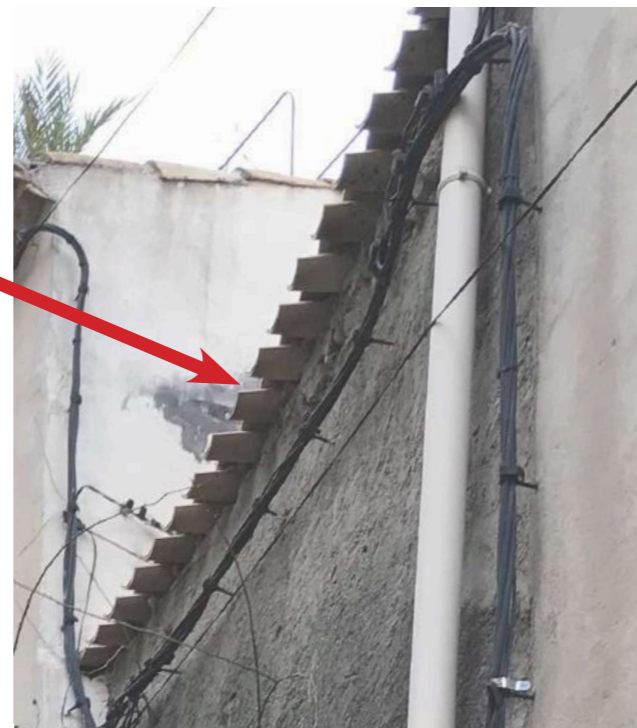
Exemple de système d'évacuation des eaux traditionnel
