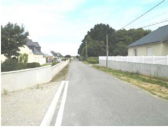
Impasse de Coat Lesvorn
