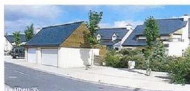
Au nord, habitation en retrait de la rue
