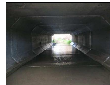
Pont-cadre situé à l'ouest du village de Saint-Pierre-de-Vassols, J.Volant, 01/12/2011.
