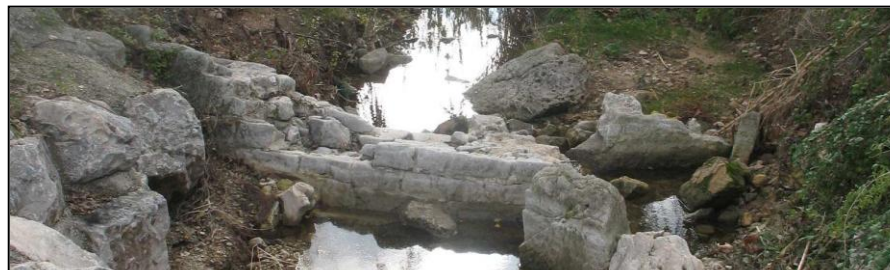
Ancien seuil traversant, partiellement franchissable par la faune piscicole, J.Volant, 01/12/2011.
