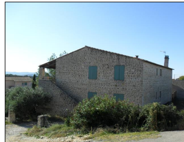
Constructions en pierre, St-Pierre-de-Vassols
