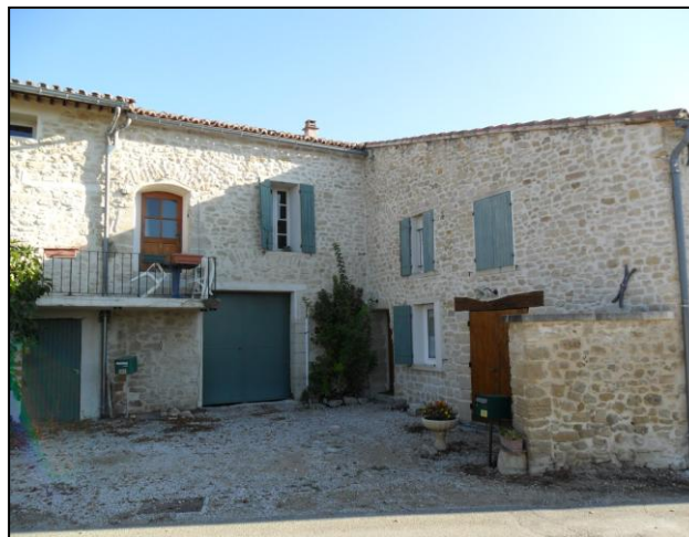
Constructions en pierre, St-Pierre-de-Vassols
