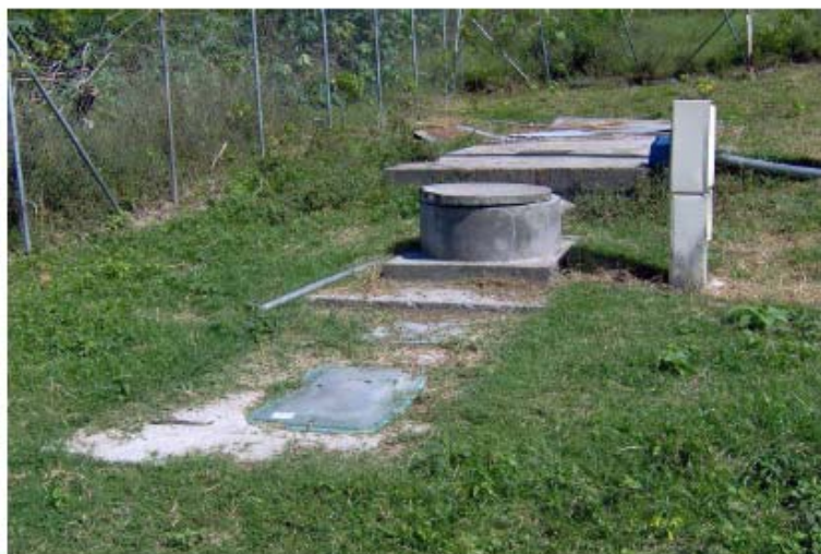
Vue d'ensemble de la station d'épuration
