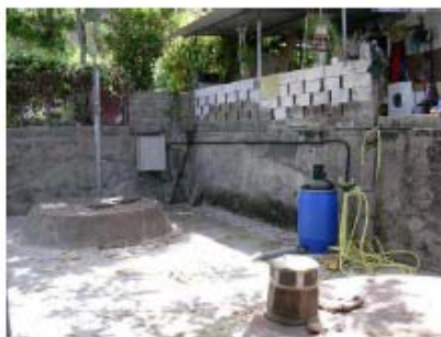
Vue d'ensemble de la station d'épuration
